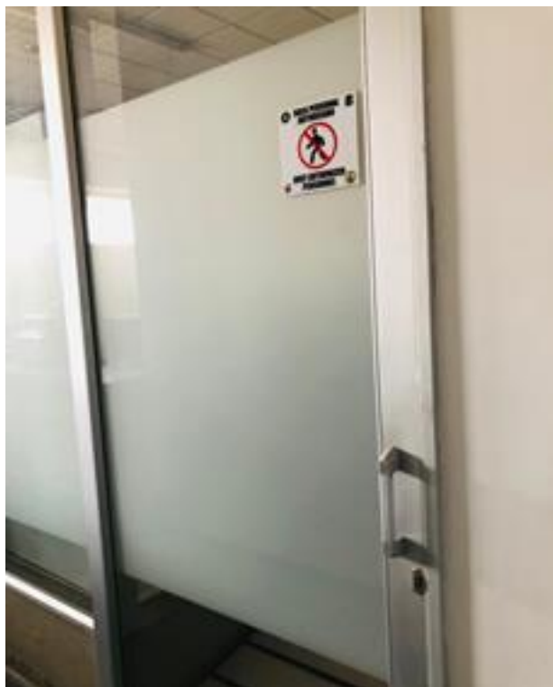
Figura 1. Puerta del centro de datos, fuente: propia.
