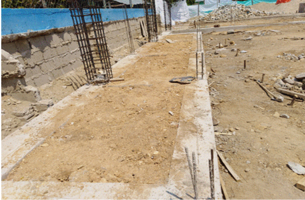
Figura 16. Actividad de relleno y compactación manual (vibrocompactador tipo rana) de material seleccionado en cajones de gradería
