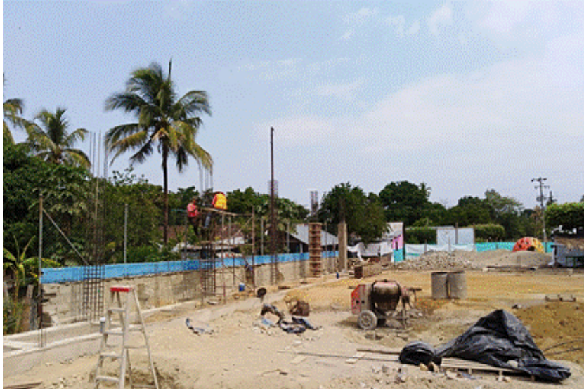
Figura 18. Ejecución de las actividades contractuales durante la semana 8
