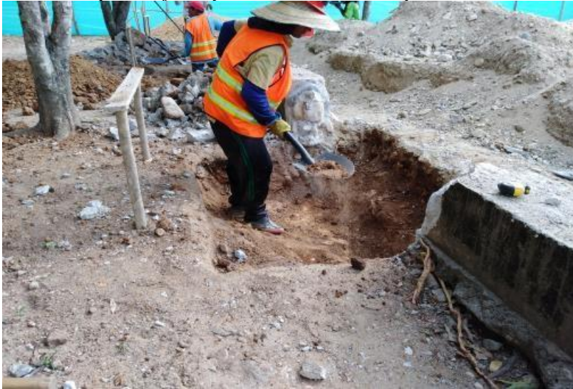
Figura 9. Excavación de zapatas ejes 1 y 2: actividad más representativa de la semana 2
