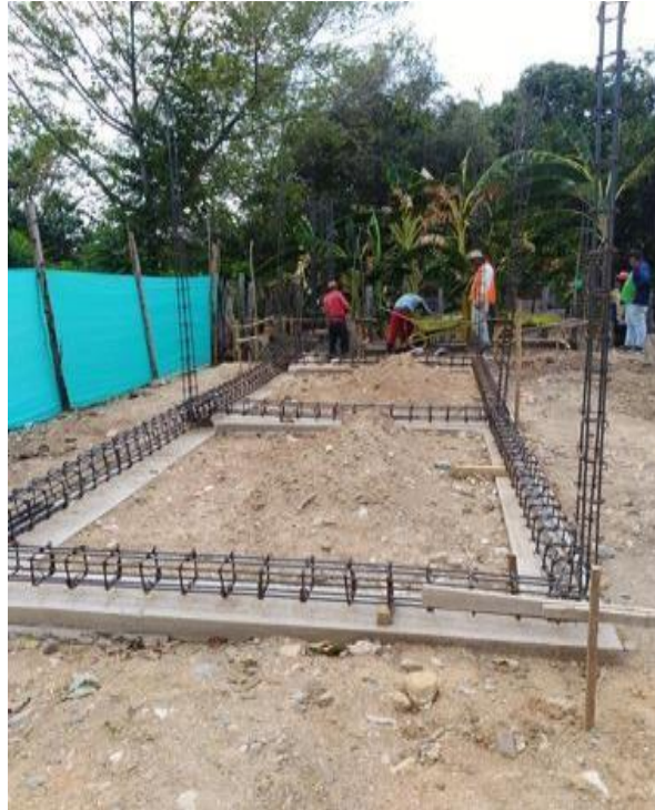
Figura 13. Armado y figurado de acero PDR 60000 PSI para las vigas de cimentación de la caseta y tarima
