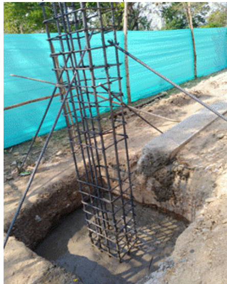
Figura 11. Zapata de dimensión (1.30mx1.30mx0.30m) fundida en concreto 3000 PSI, estructura de pedestal en acero PDR 60000 PSI, dimensión (0.50mx0.40mx0.80m)
