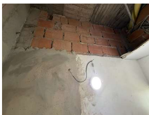
Pañete para muros en area de bodegaje, muros en cuartos de lavado, contemplando zonas superiores a las tapadas por el Drywall
