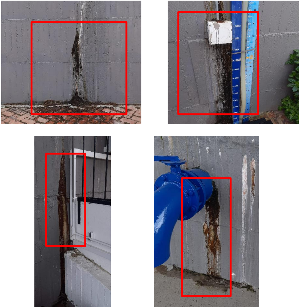
Figura 5. Visita tanque Centro.
