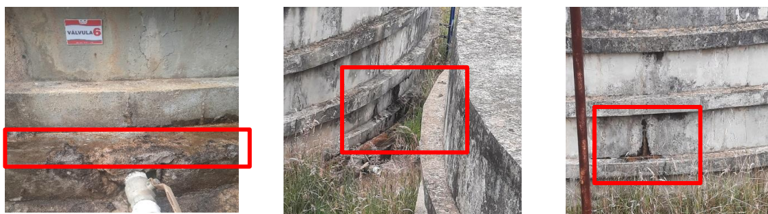
Figura 9. Visita tanques El Triunfo No. 1 y 2.
