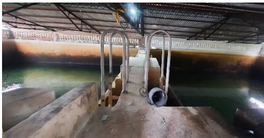
Figura 12. Visita tanques Gemelos No 1 y 2.
