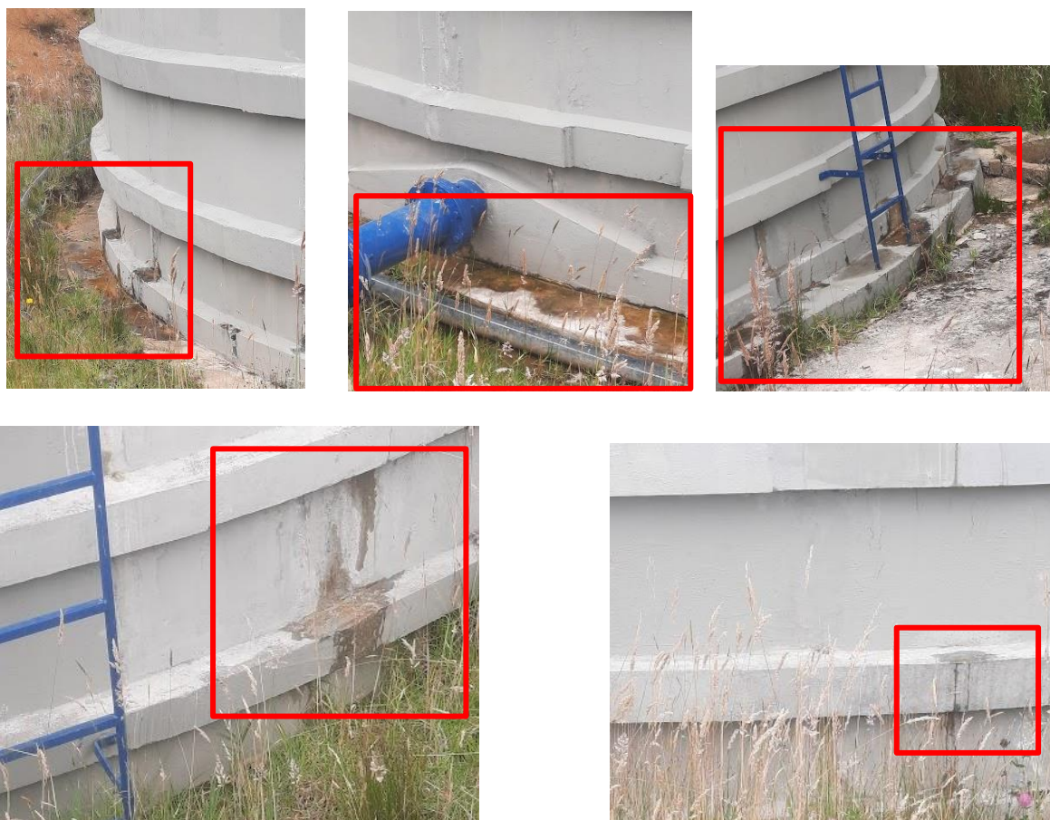
Figura 13. Visita tanques Milagro Redondos No 1 y 2.
