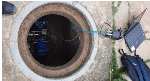
Figura 31. Conexión de Logger a Computador.
