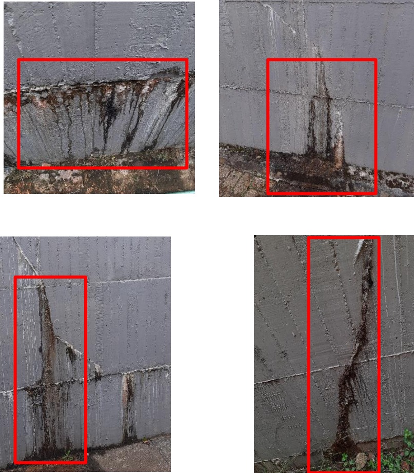
Figura 4. Visita tanques Oriente No 1.
