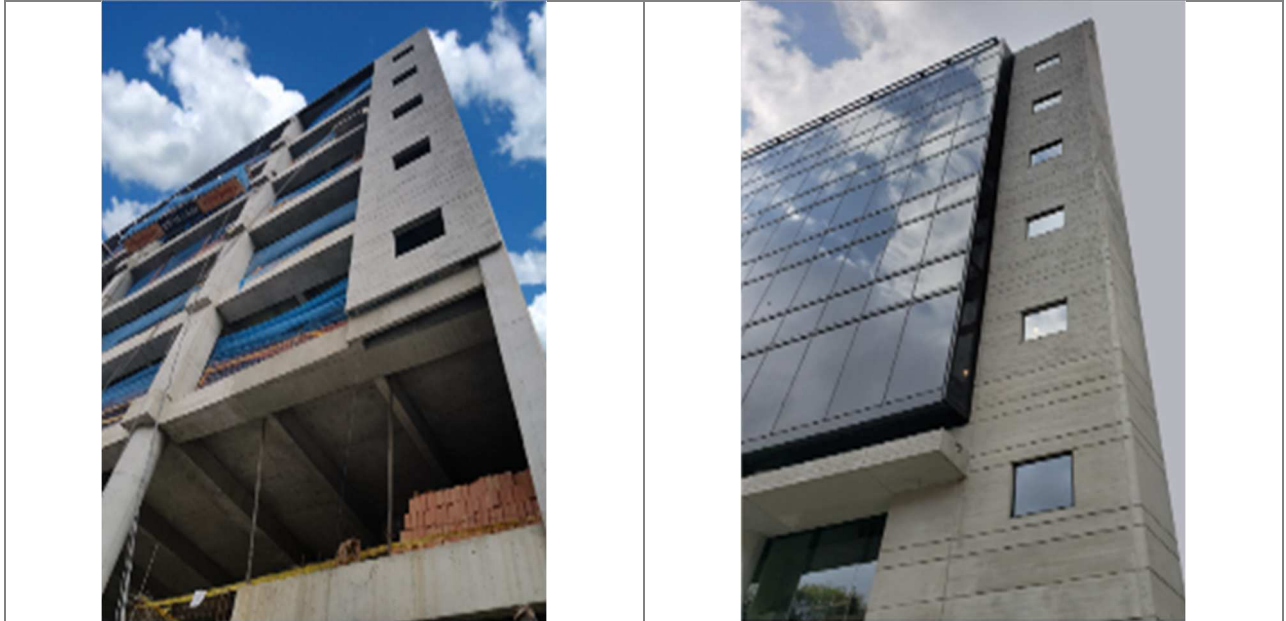
Figura 15. Proceso constructivo doble fachada.
