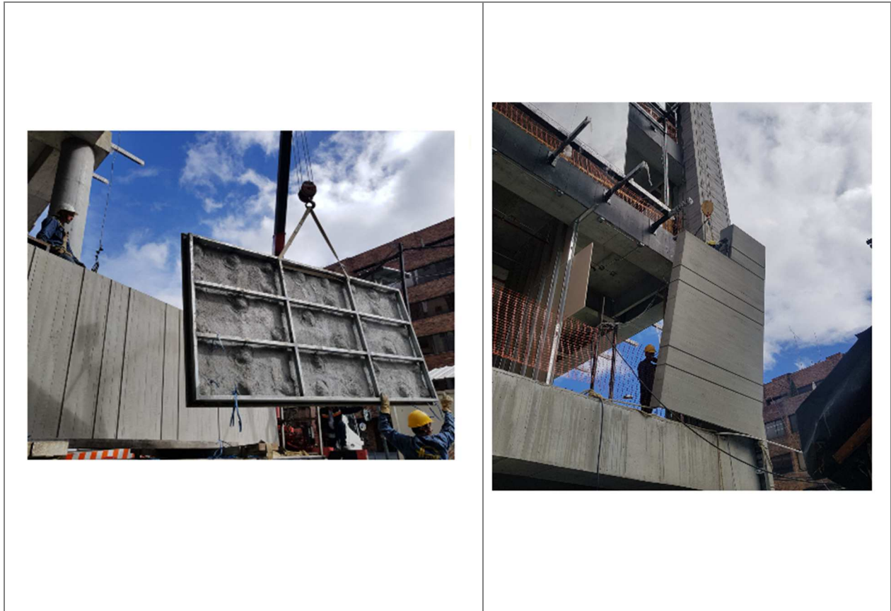
Figura 14. Proceso de instalación paneles prefabricados en concreto GRC
