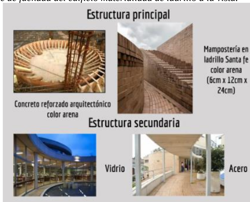
Figura 8. Detalle de fachada del edificio materialidad de ladrillo a la vista.
