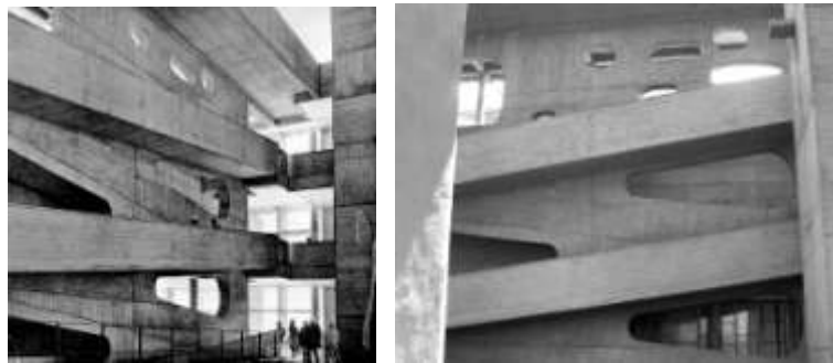
Fotografía de rampa del edificio del Tribunal Superior de Chandigarh,
