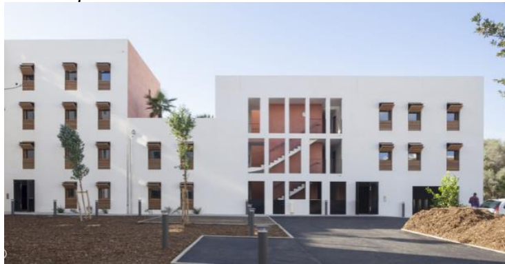
Figura 21. Patio central edificio Antibes
