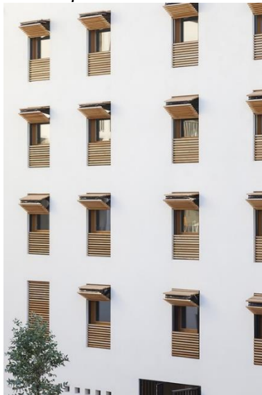
Figura 25. Detalle parasoles ventana edificio Antibes
