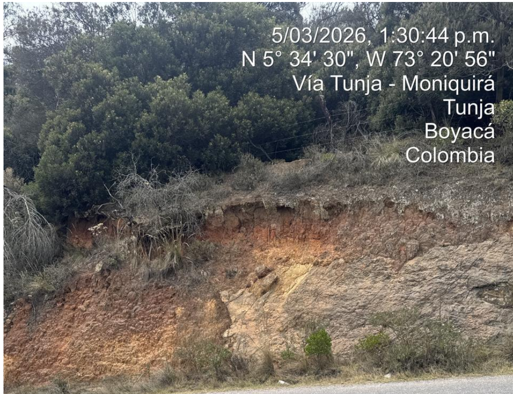
Figura 6 Talud de estudio Vista Frontal
