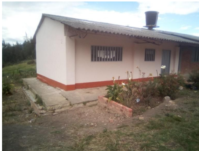
Imagen 20. Fotografía salón de clases actualmente parte externa Fuente: fotografía tomada por el autor.
