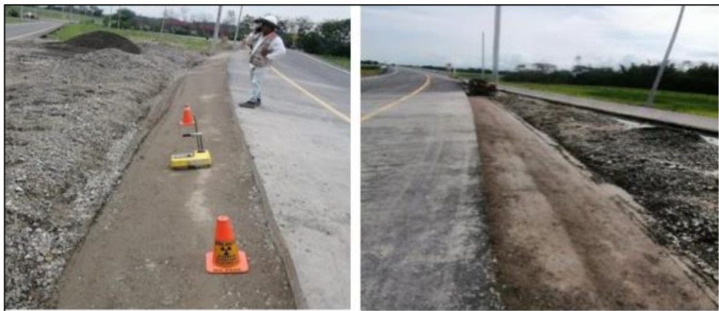
Figura 11. Inspección de cunetas de la unidad funcional 1. Fuente: (Corredor Fabian, 2022)
