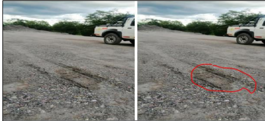
Figura 16. Inspección de terraplén <3" de unidad funcional 1.
