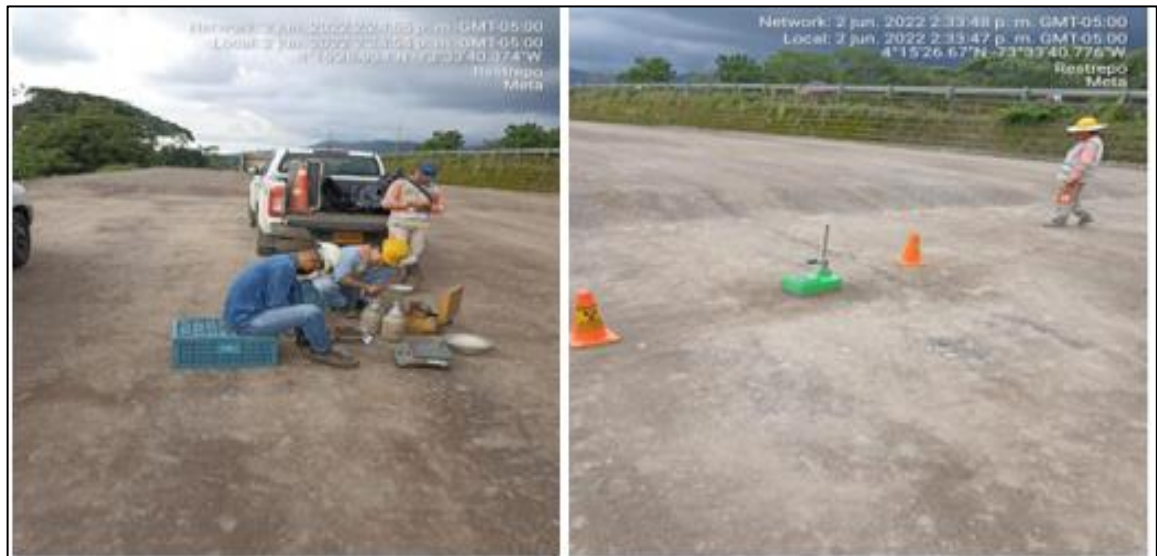
Figura 20. Inspección de terraplén <4in. Fuente: (Corredor Fabian, 2022).
