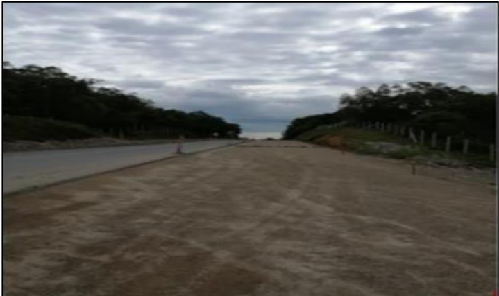
Figura 9. Verificación del tramo k0+150 al k0+420. (Fuente: Autor,2022)
