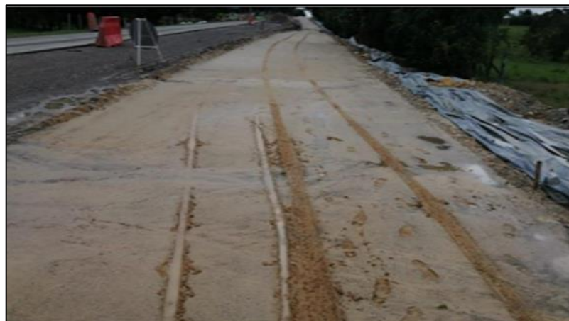
Figura 17. Inspección corona 1 de unidad funcional 2. Fuente: (Corredor Fabian, 2022).
