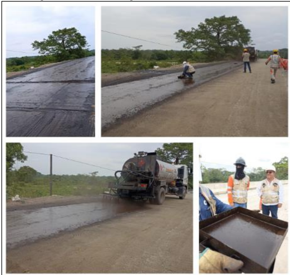
Figura 18. Control de imprimación unidades funcional 3. Fuente: (Corredor Fabian, 2022).
