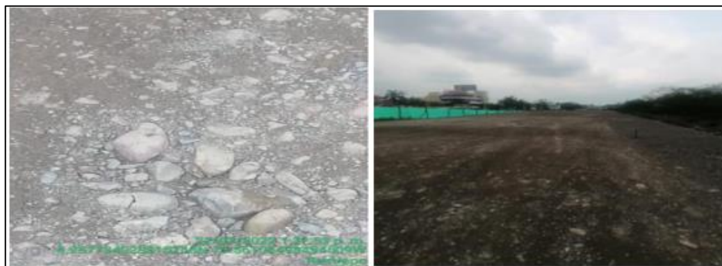
Figura 12. Inspección de base granular unidad funcional 1. Fuente: (Corredor Fabian, 2022)
