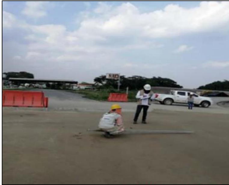
Figura 14. Inspección de base granular de unidad funcional 1. Fuente: (Corredor Fabian, 2022).
