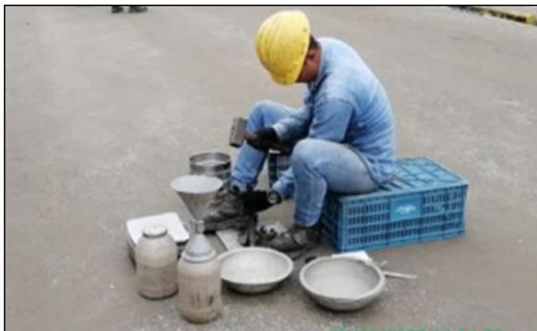
Figura 15. Inspección de base granular de unidad funcional 1. fuente: (Corredor Fabian, 2022).
