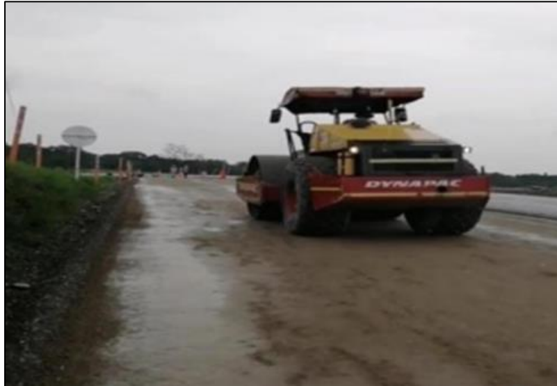
Figura 13. Inspección del terraplén<4 de unidad funcional 1. Fuente: (Corredor Fabian, 2022).
