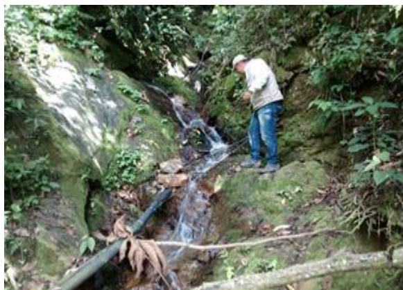
Captación en la naciente Mata de Zinc Fuente: autor de la tesis
