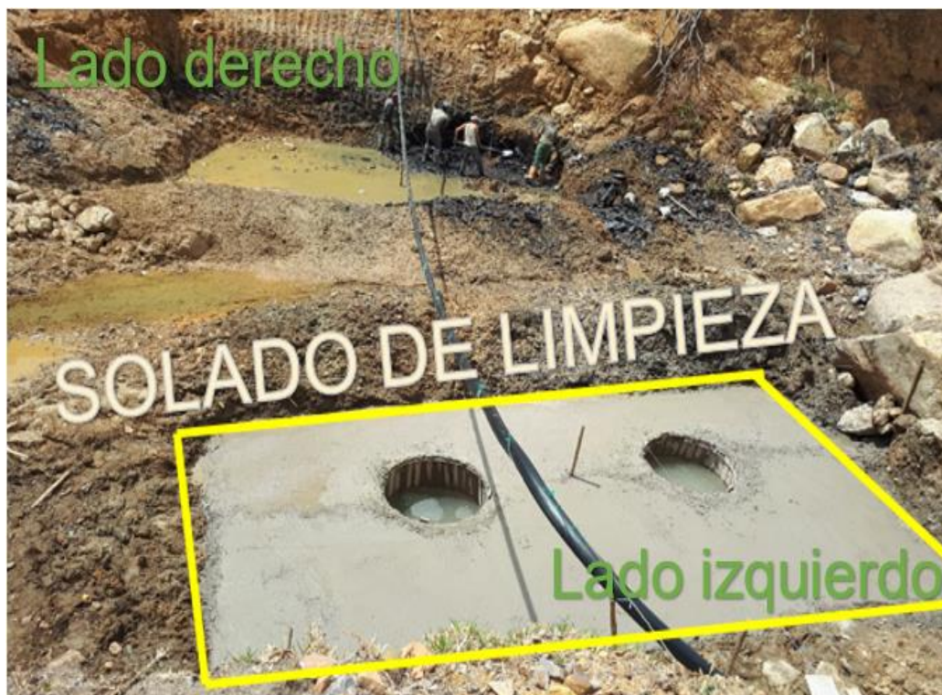
Figura 12. Fotografía: Avance Puente Chinguichanga
