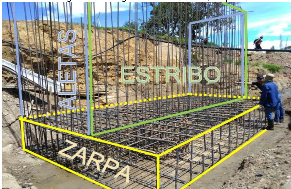
Figura 18. Fotografía: estribo, aletas, zarpa
