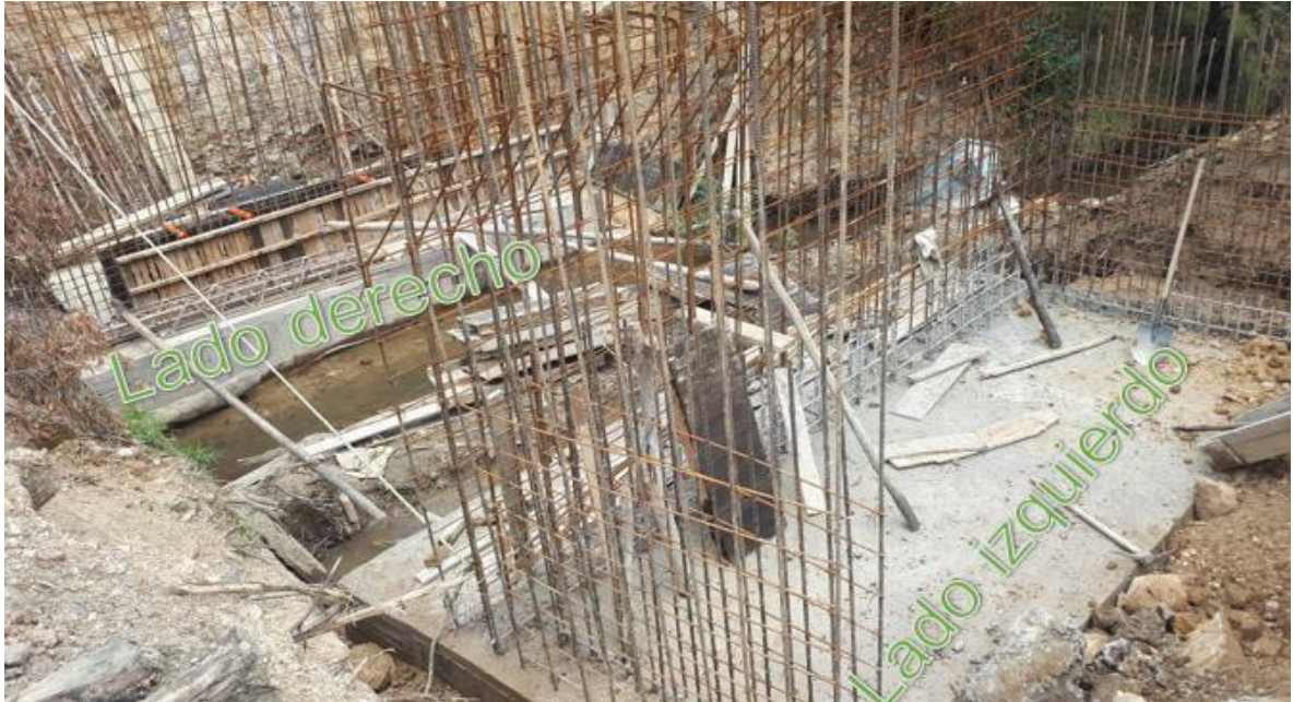
Figura 15. Fotografía: Avance Puente Gachaneca.
