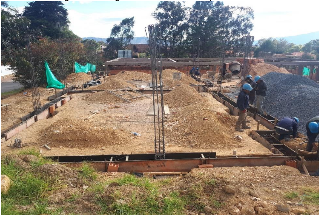
Figura 7. Fotografía del muro de Bloque de Aulas N° 3
