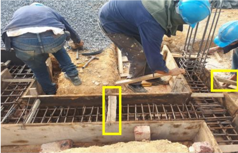
Figura 8. Fotografía: vigas de cimentación
