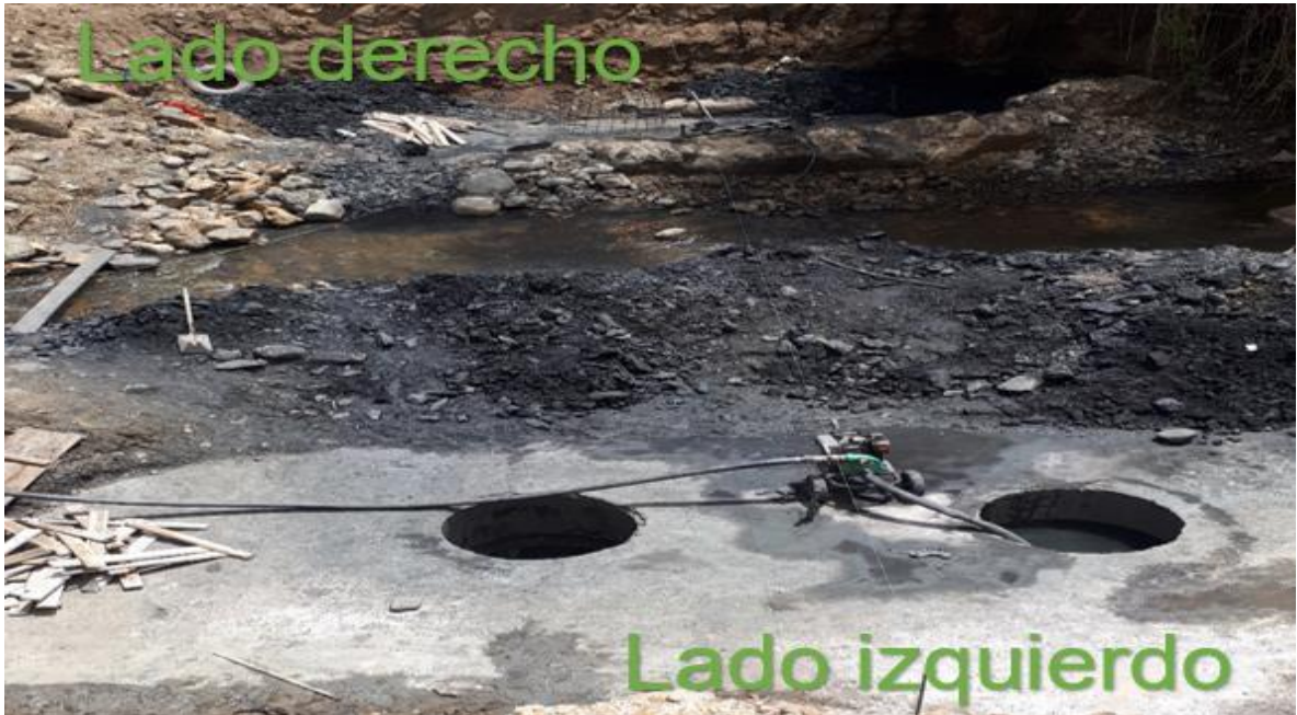
Figura 13. Fotografía: Avance puente candelaria oriente.
