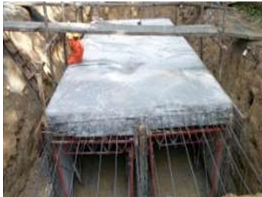
Figura 17. Losa superior fundida
