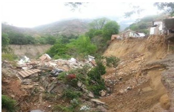
Figura 9. Desprendimiento talud
