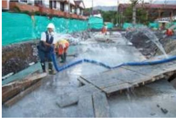
Figura 17. Losa superior fundida
