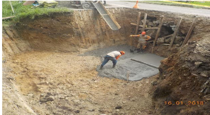
Figura 10. Solado de limpieza
