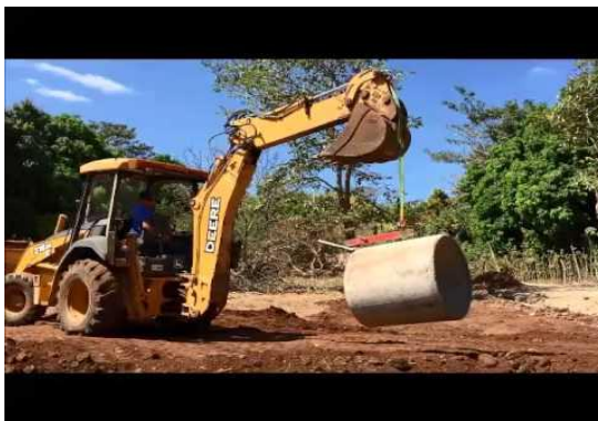
Figura 5. Instalación tubería 36”
