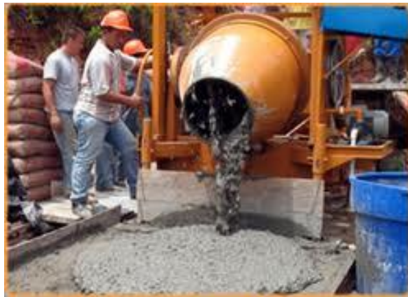
Figura 13. Mezclado concreto 4000 psi
