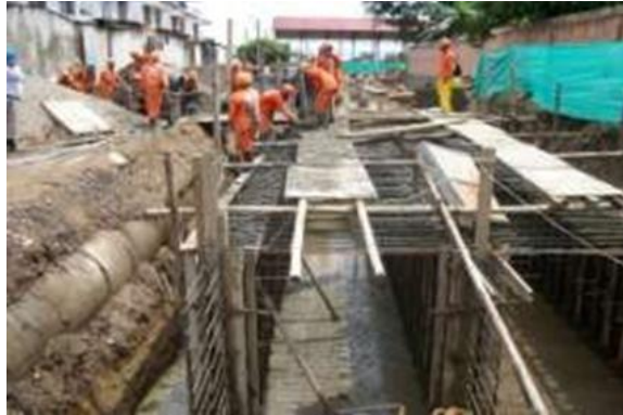
Figura 14. Encofrado placa superior
