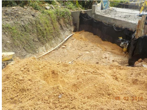
Figura 18. Relleno estructura nivel de via
