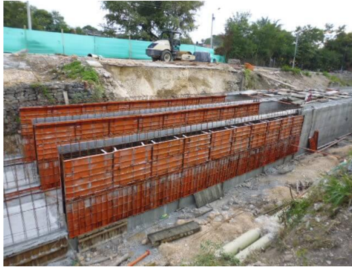
Figura 12. Encofrado muros laterales
