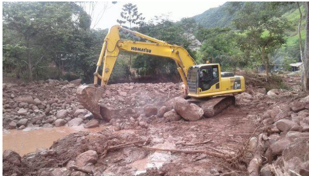
Figura 19. Encause de rio hacia el box
