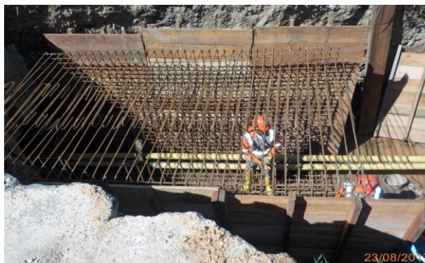
Figura 11. Instalación acero
