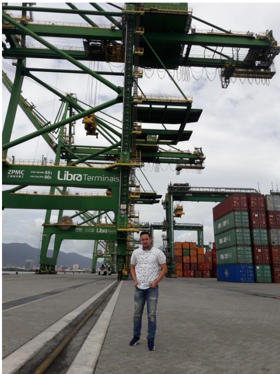
Figura No 10. Grúas porticas en puerto de rio
