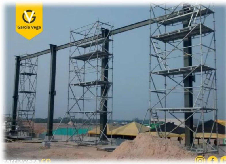
Figura 8. Ensamble con andamios
