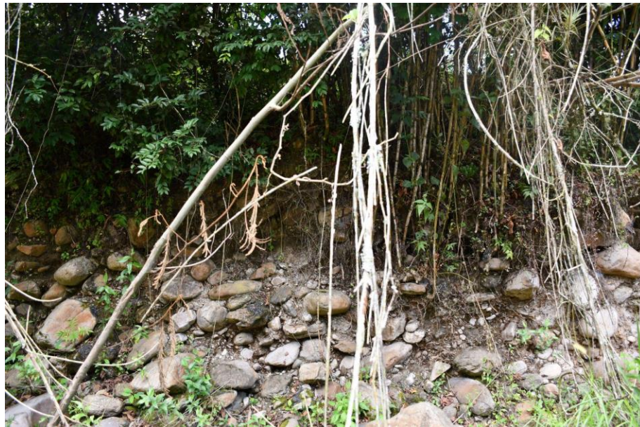
Fotografía 2. Deslizamiento de las orillas del terreno del río Garagoa en verano.
