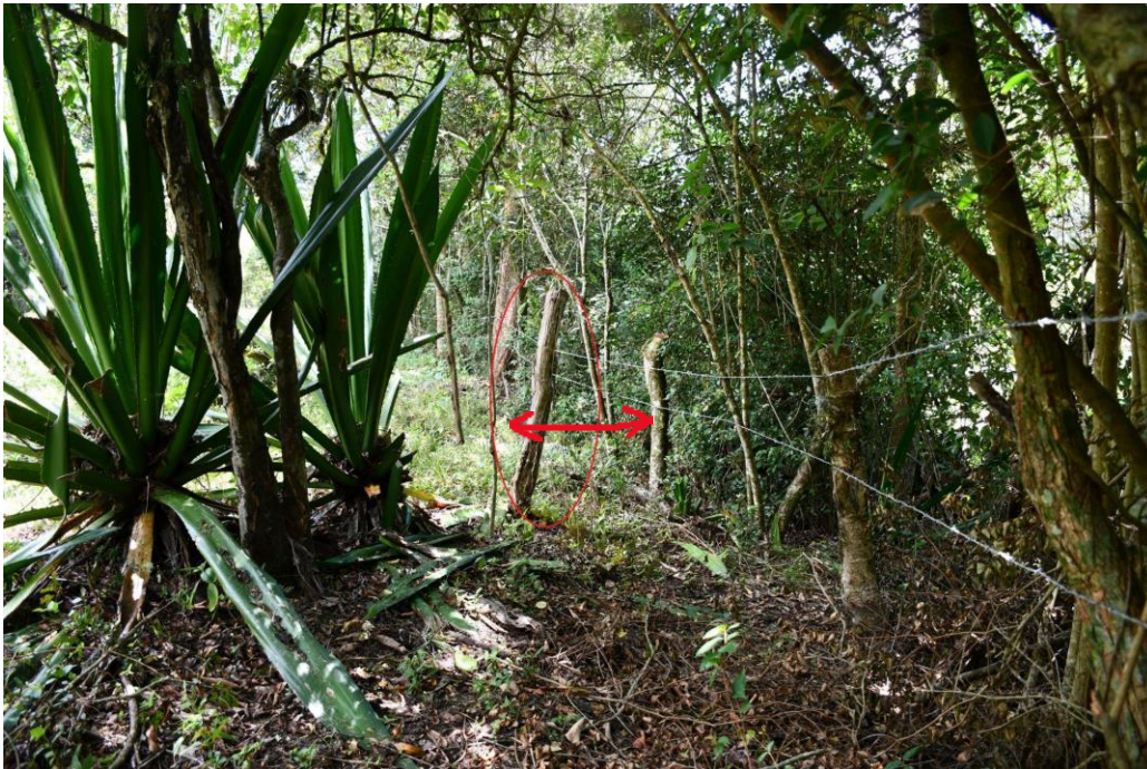
Fotografía 1. Recercamiento por desplazamiento del suelo
