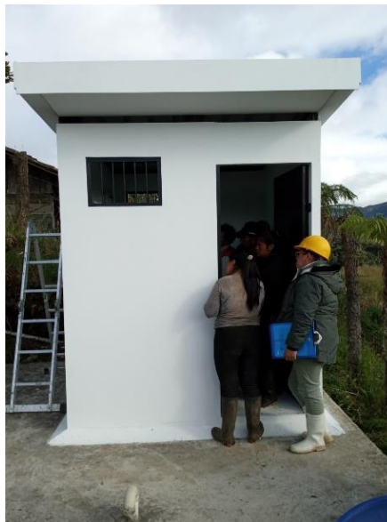
Figura N° 17. Nueva Caseta dotada con Paneles
