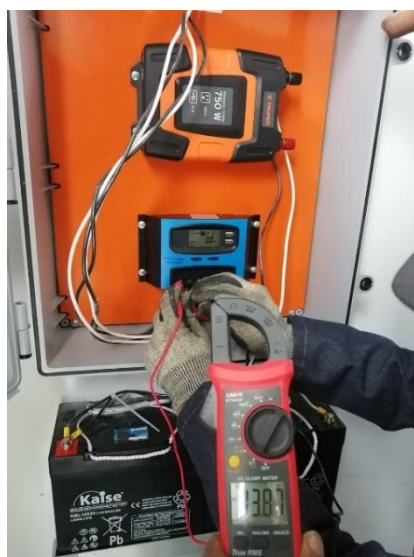
Figura N ° 9. Circuito eléctrico del inversor de energía solar a energía eléctrica
