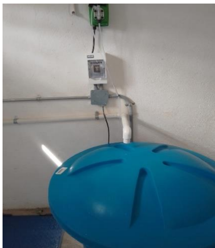
Figura N° 7. tanque dosificador con sonda para hacer succión del desinfectante
