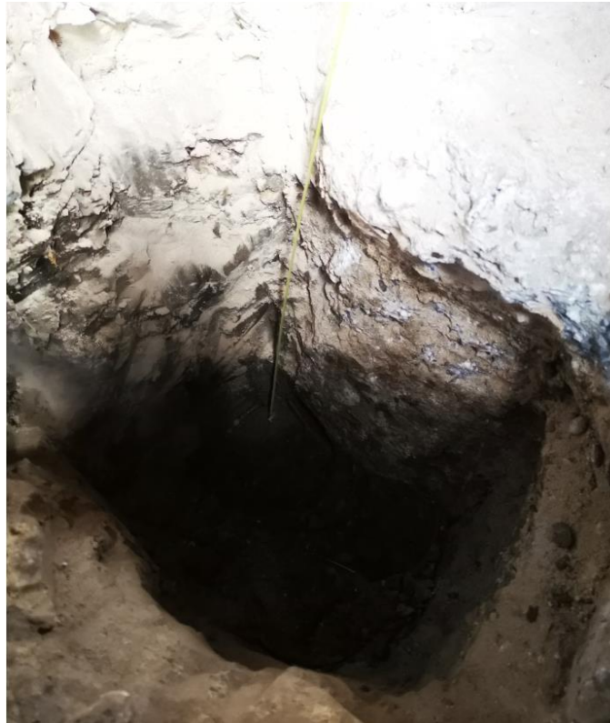
Fotografía 36. Detalle de apique junto a cimentación finalizado
