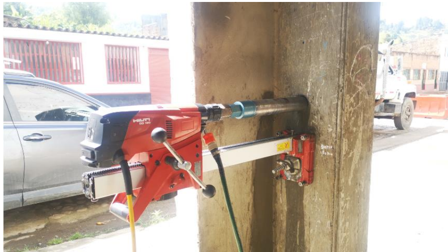
Fotografía 17. Extracción de núcleos – Columna 1 (cara lateral)
