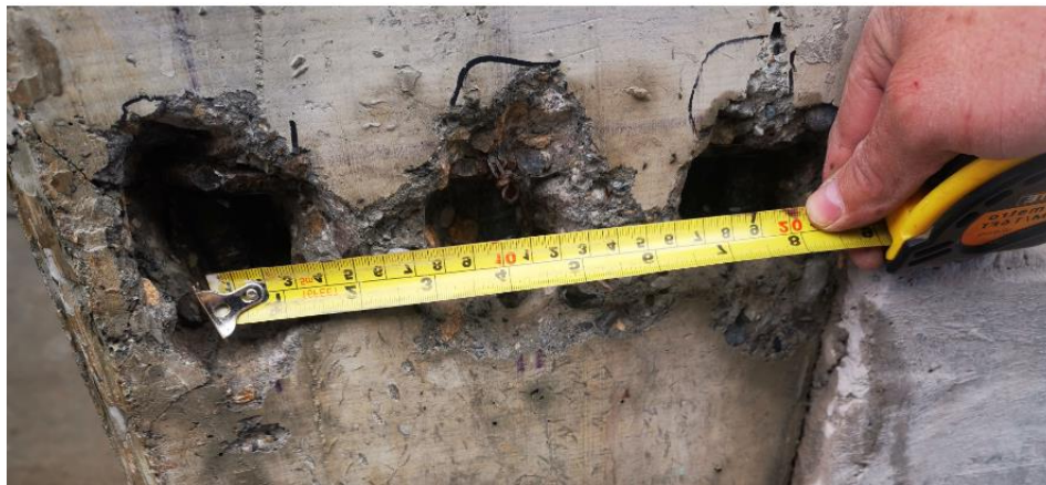
Fotografía 25. Distancia entre refuerzo vertical – Columna 3
