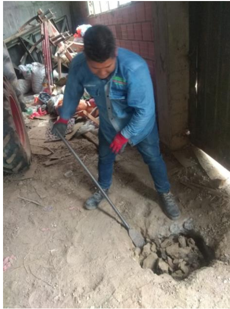
Fotografía 5. Apiques realizados en la estructura para establecer el tipo de cimentación existente. Fuente: Propia.
