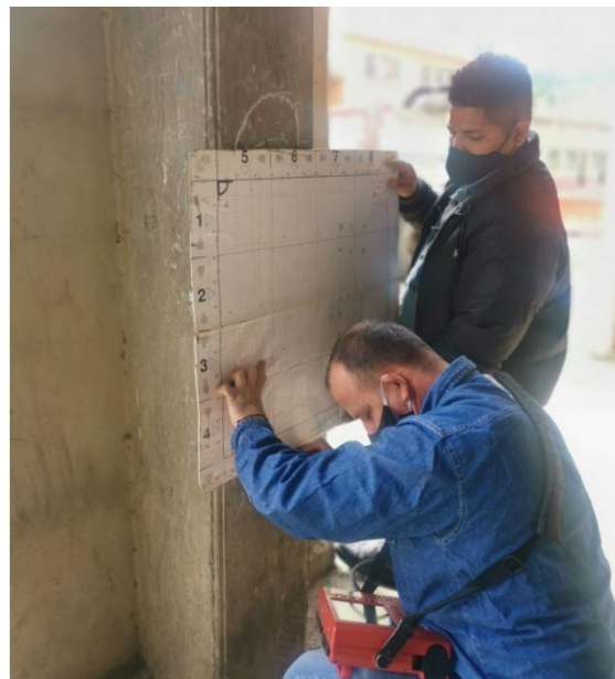
Fotografía 7. Escáner de refuerzo horizontal – Columna 1 (cara interior)
