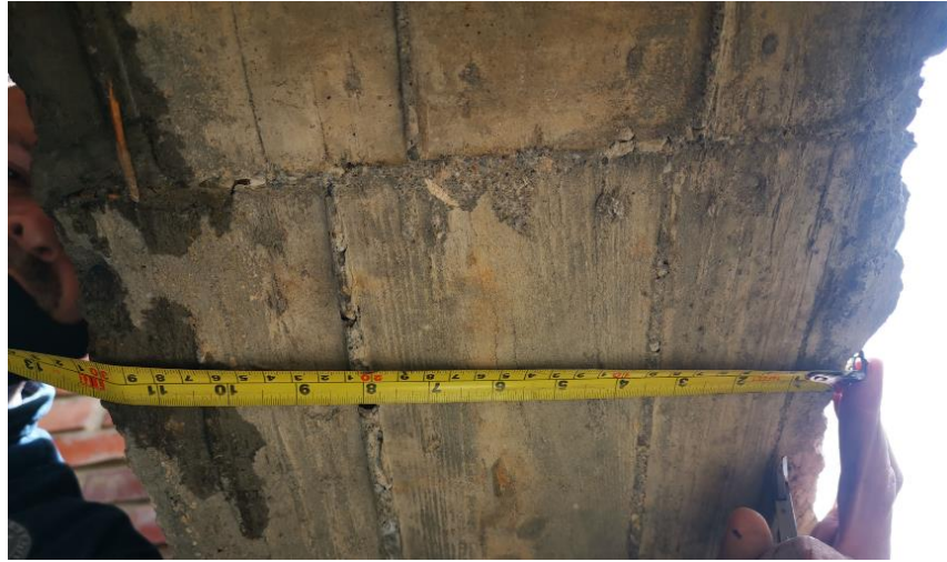
Fotografía 34. Medición de ancho de viga
