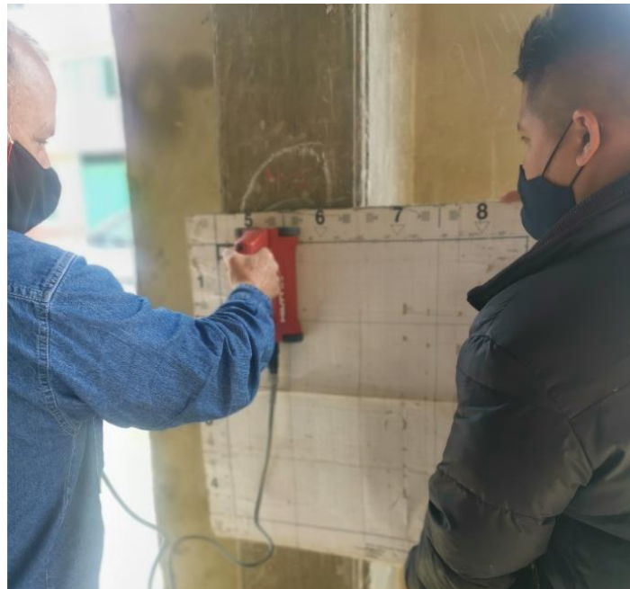
Fotografía 6. Escáner de refuerzo vertical – Columna 1 (cara interior)
