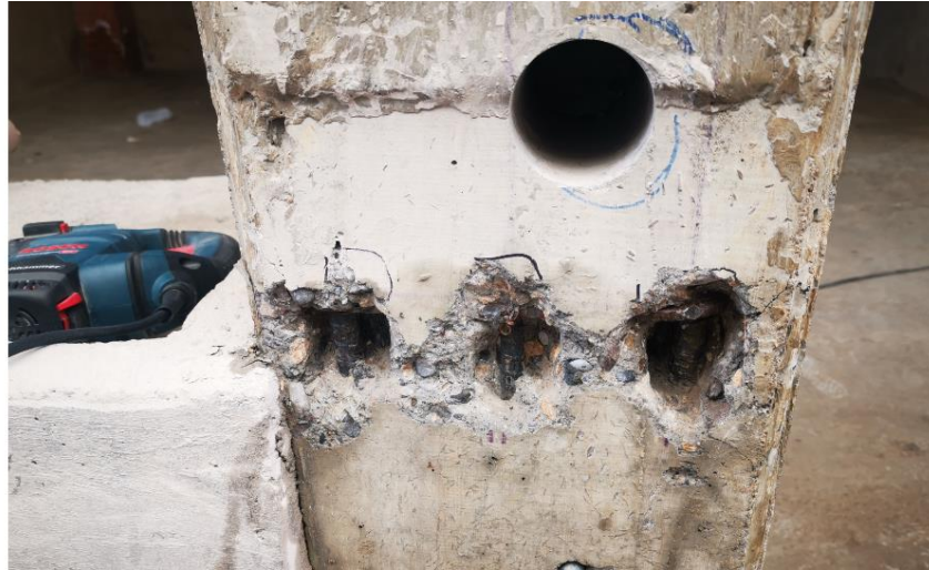
Fotografía 24. Regatas para verificación de refuerzo – Columna 3
