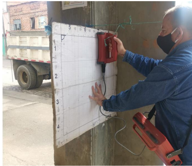
Fotografía 8. Escáner de refuerzo vertical – Columna 1 (cara lateral)
