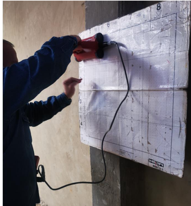
Fotografía 12. Escáner de refuerzo vertical horizontal – Columna 2 (cara lateral)
