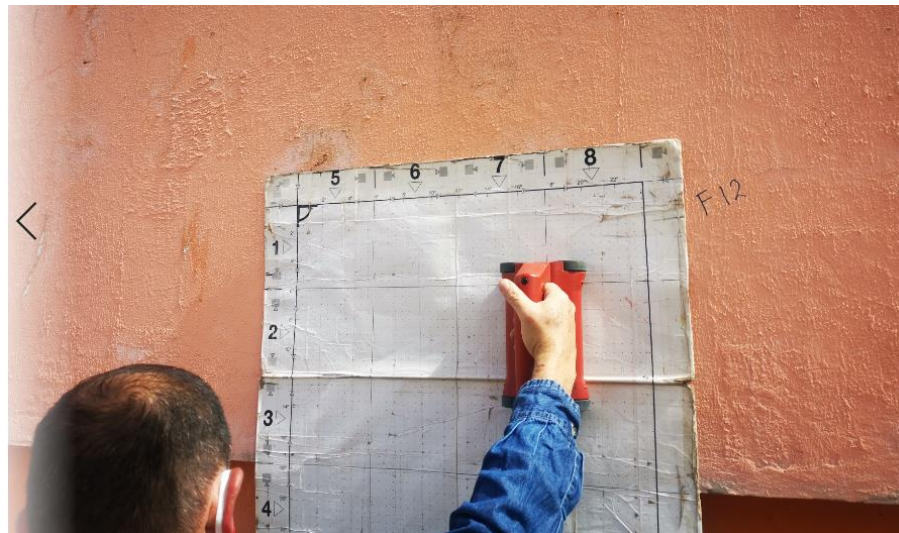
Fotografía 15. Escáner de refuerzo vertical inferior – Muro (cara interior)
