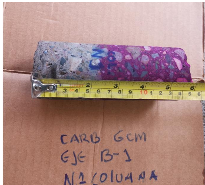
Fotografía 21. Medición de carbonatación – Columna 1
