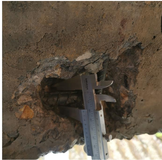
Fotografía 32. Medición diámetro refuerzo principal inferior – Viga
