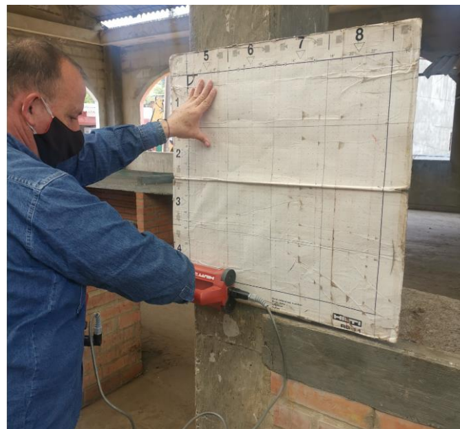
Fotografía 9. Escáner de refuerzo vertical – Columna 1 (cara lateral)
