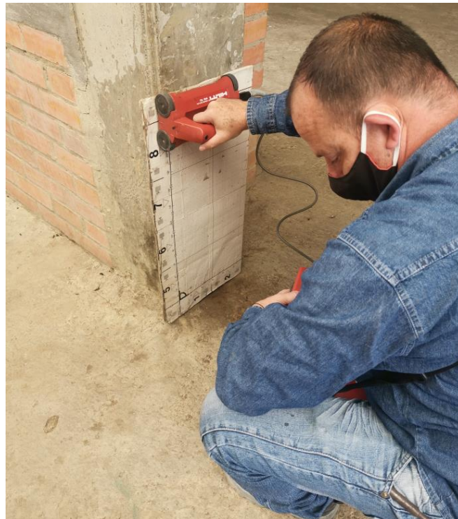
Fotografía 11. Escáner de refuerzo horizontal inferior – Columna 1 (cara lateral)
