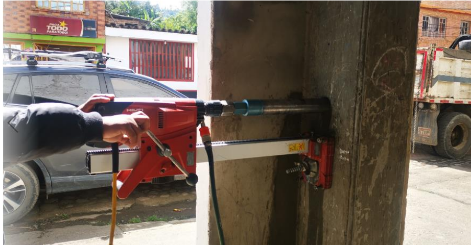
Fotografía 16. Extracción de núcleos – Columna 1 (cara lateral)
