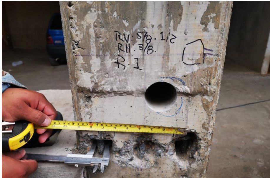
Fotografía 28. Medición general de diámetro refuerzo vertical y separación – Columna 3
