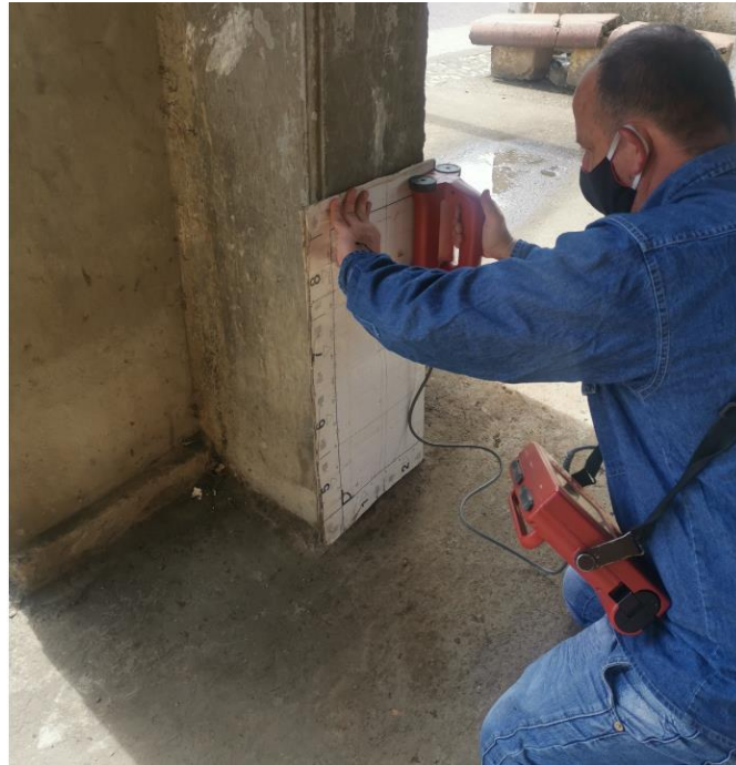
Fotografía 10. Escáner de refuerzo vertical inferior – Columna 1 (cara interior)
