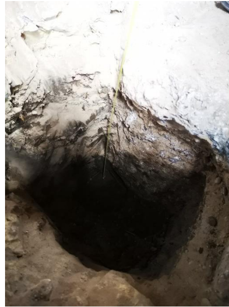
Fotografía 5. Apiques realizados en la estructura para establecer el tipo de cimentación existente. Fuente: Propia.
