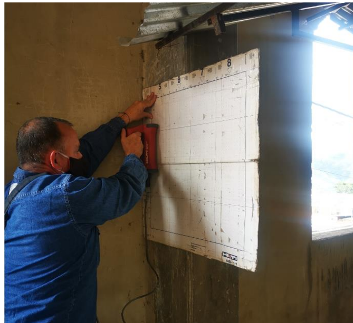
Fotografía 13. Escáner de refuerzo vertical – Columna 2 (cara lateral)
