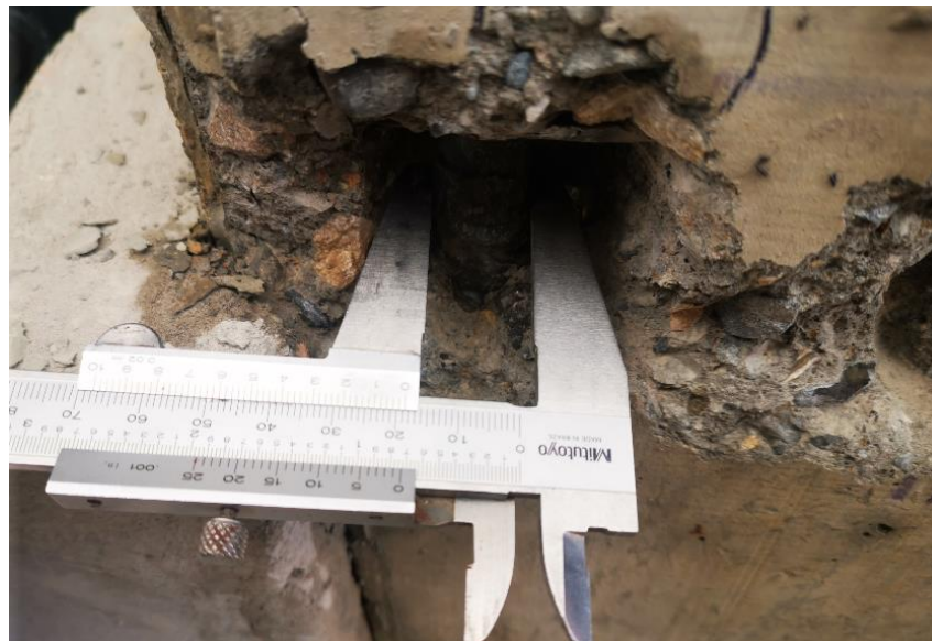
Fotografía 27. Medición diámetro refuerzo vertical extremo – Columna 3
