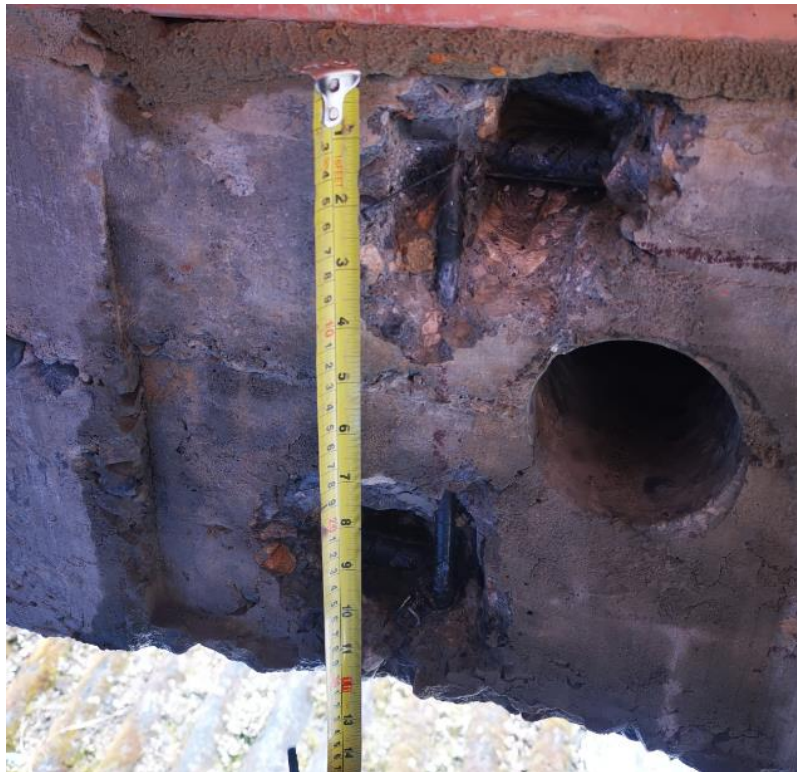
Fotografía 33. Medición distancia entre refuerzos superior e inferior – Viga
