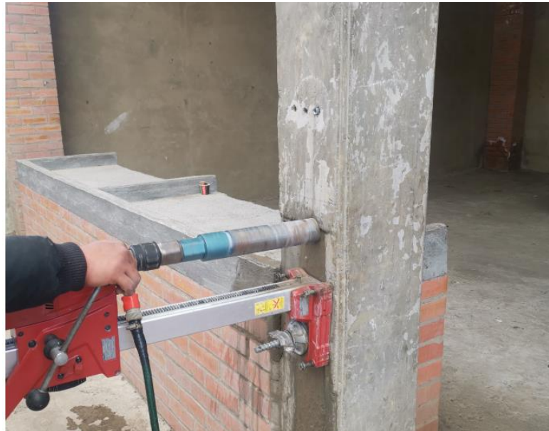
Fotografía 19. Extracción de núcleos – Columna 3 (cara lateral)
