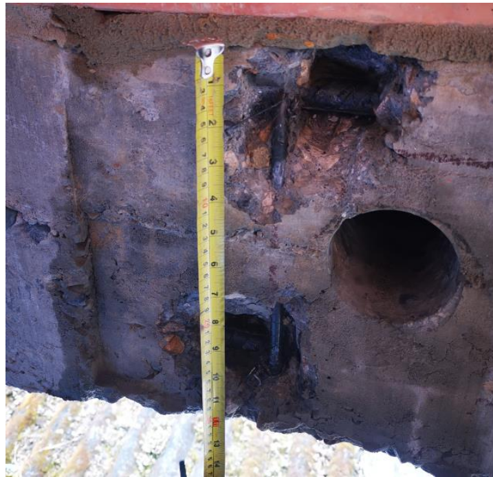
Fotografía 20. Extracción de núcleos – Viga (cara interior)
