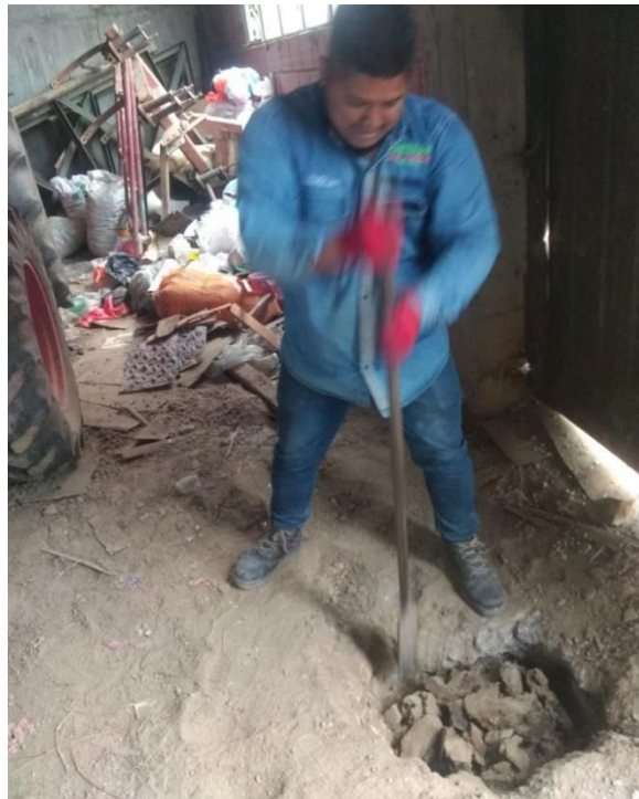
Fotografía 35. Inicio de ejecución apique junto a cimentación
