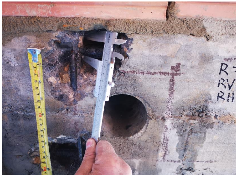
Fotografía 31. Medición separación refuerzo horizontal – Viga
