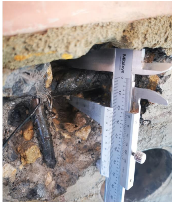
Fotografía 30. Medición diámetro refuerzo principal superior – Viga
