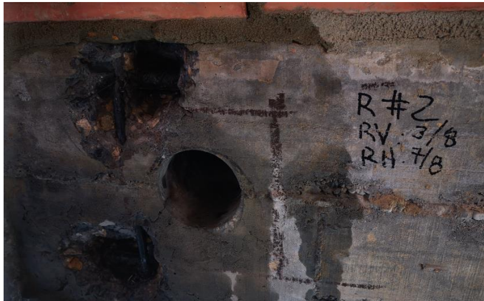
Fotografía 29. Regatas para verificación de refuerzo – Viga
