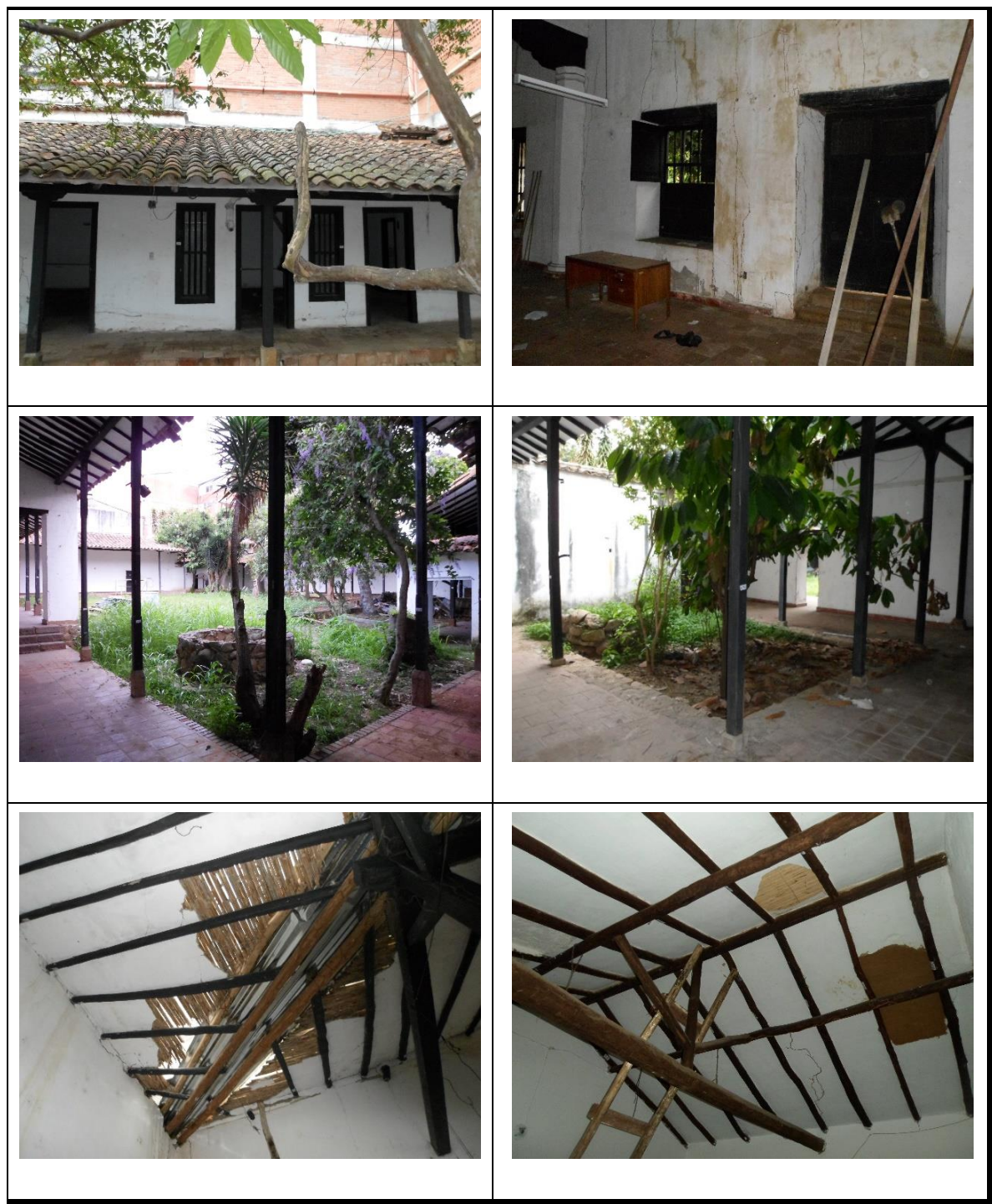
Figura 71. Levantamiento fotográfico estado actual 3. Tomadas: entre el día 13 y 14 de octubre 2015.
