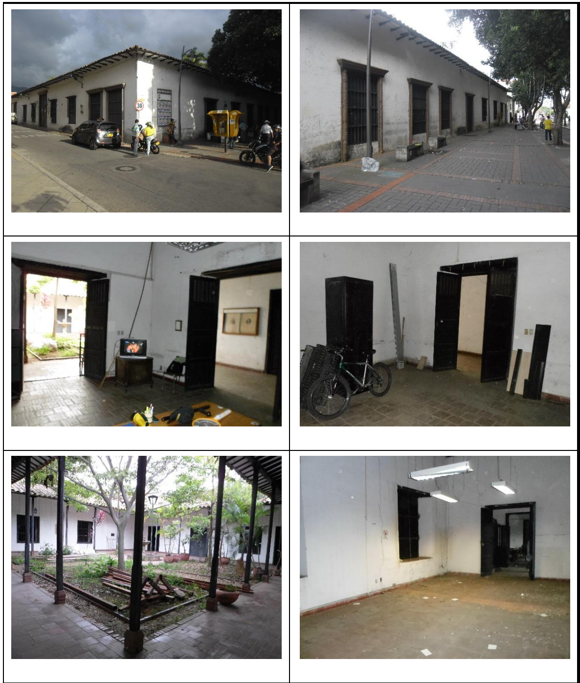
Figura 69. Levantamiento fotográfico estado actual 1. Tomadas: entre el día 13 y 14 de octubre 2015.
