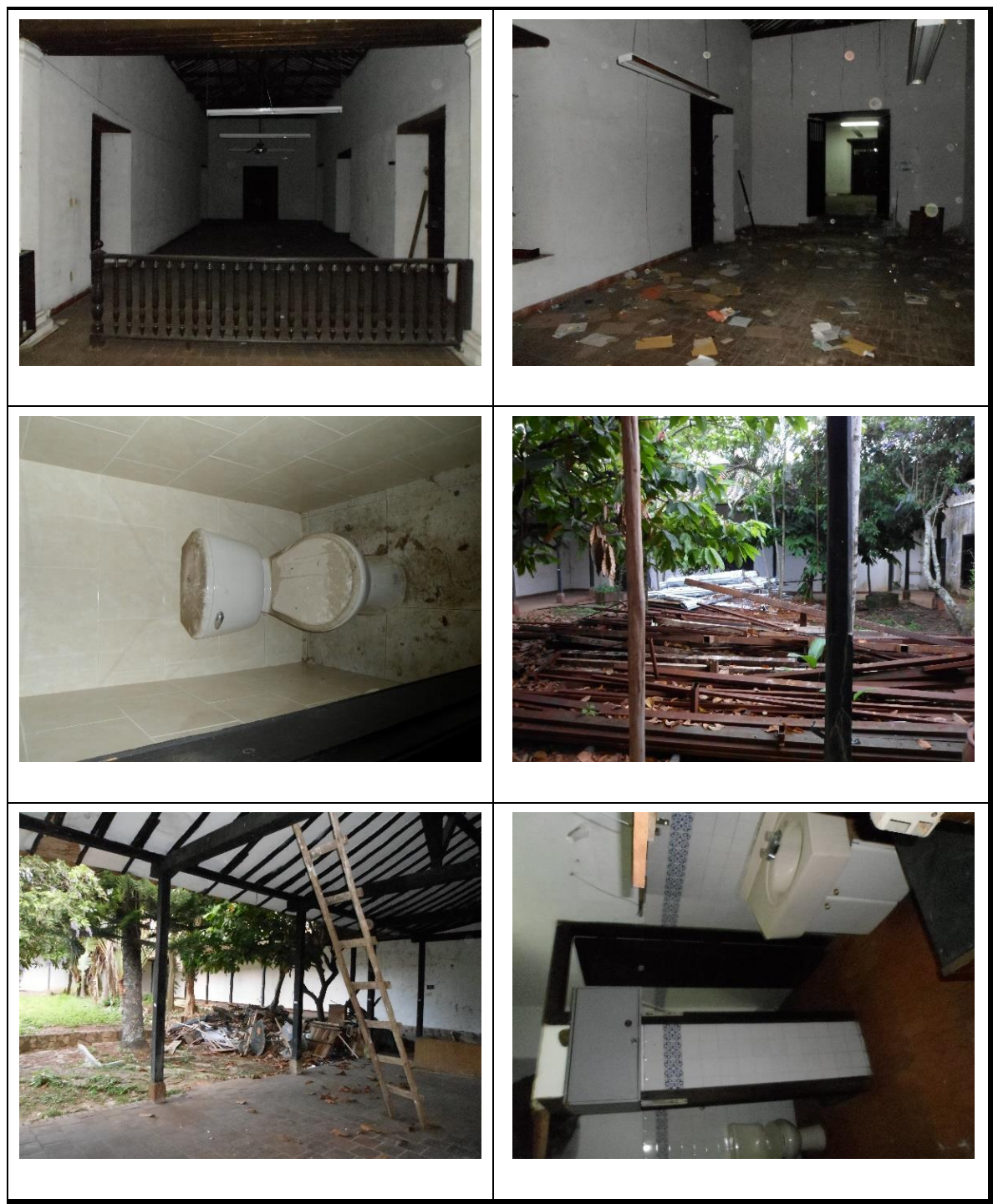
Figura 70. Levantamiento fotográfico estado actual 2. Tomadas: entre el día 13 y 14 de octubre 2015.
