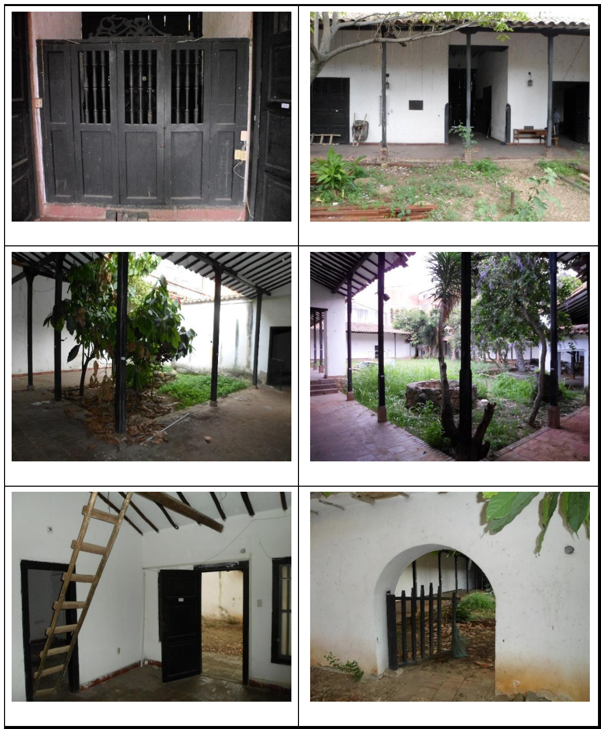
Figura 72. Levantamiento fotográfico estado actual 4. Tomadas: entre el día 13 y 14 de octubre 2015.
