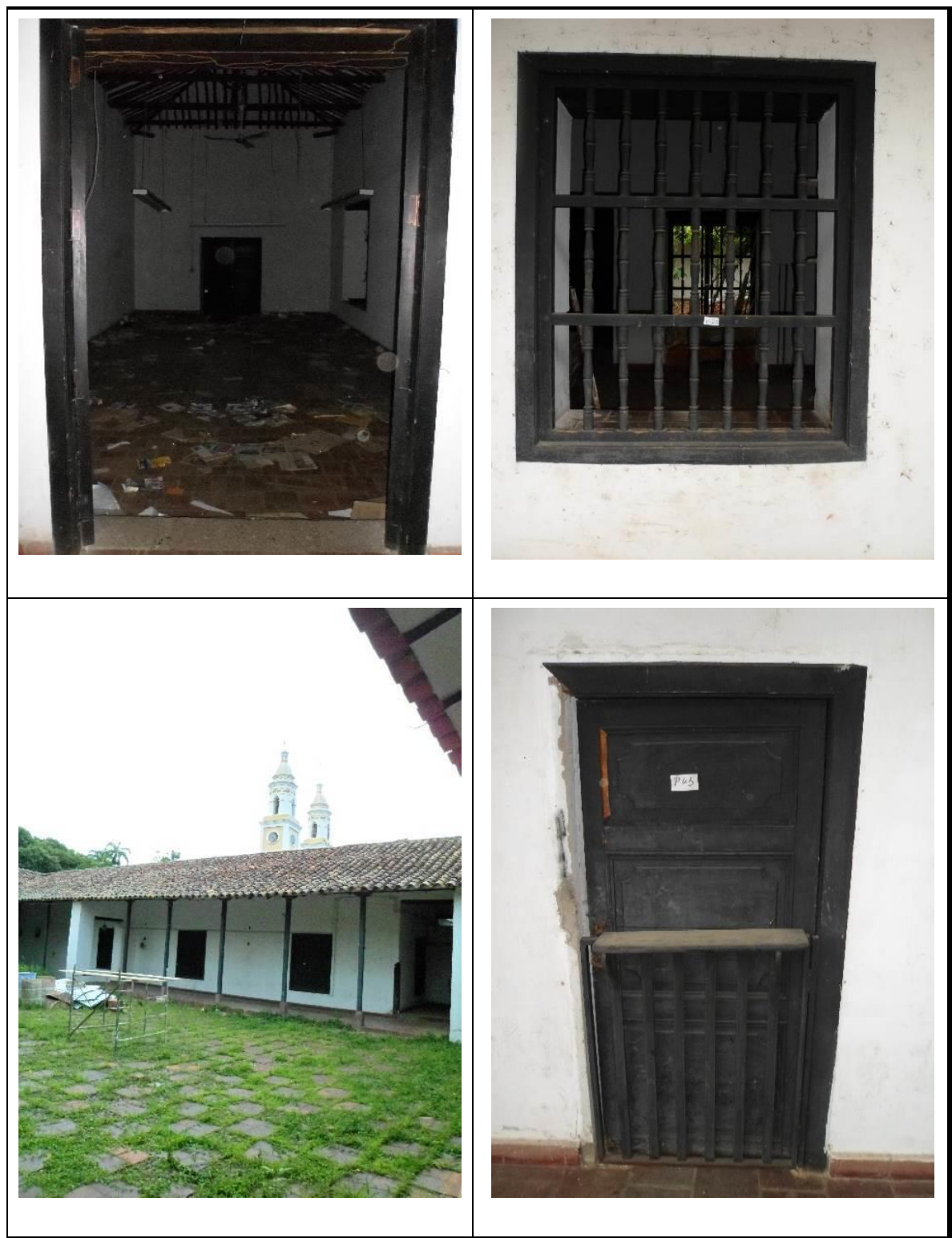
Figura 73. Levantamiento fotográfico estado actual 5. Tomadas: entre el día 13 y 14 de octubre 2015.
