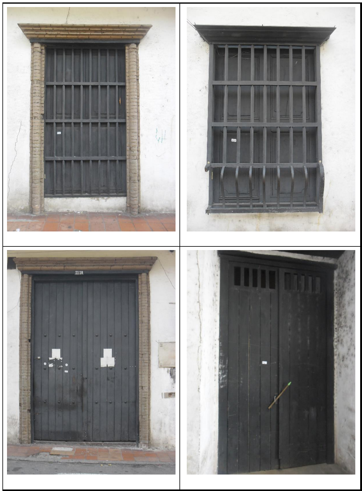
Figura 74. Levantamiento fotográfico estado actual 6. Tomadas: entre el día 13 y 14 de octubre 2015.
