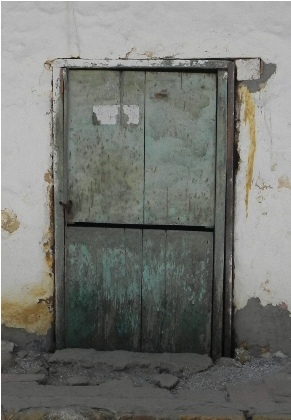
Figura 65. Puerta acceso principal T2. Adaptada de "Archivo", archivo autor, 2013
