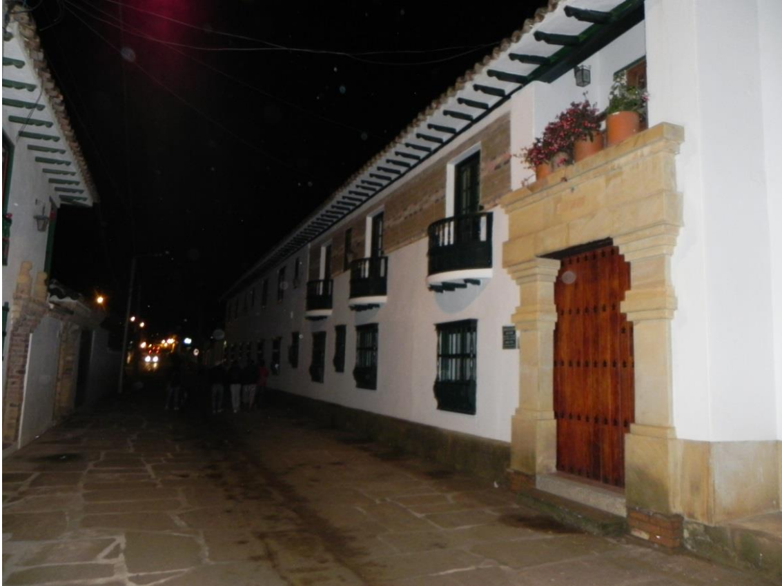
Figura 21. Fachada vivienda Villa de Leyva del siglo XIX. Adaptada de "Archivo", archivo autor, 2012
