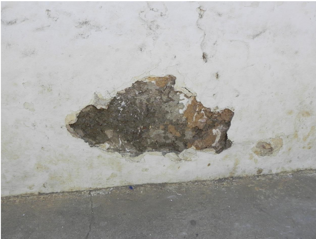
Figura 105. Muro en tapia expuesto. Adaptada de "Archivo", archivo autor, 2015
