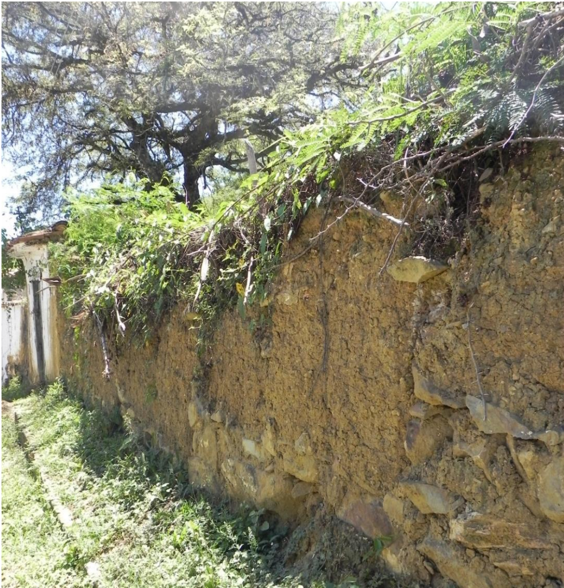
Figura 15. Ruinas muro en tapia. Adaptada de "Archivo", archivo autor, 2012
