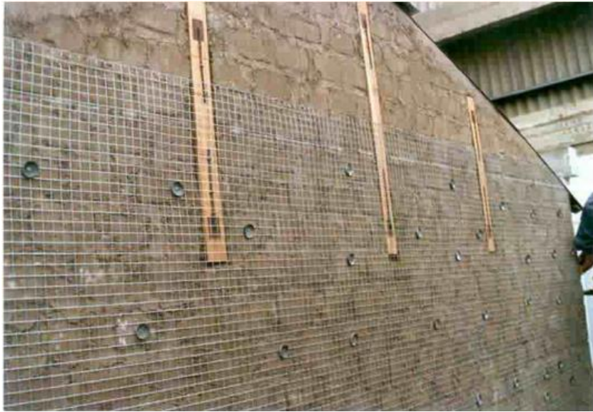
Figura 125. Detalle instalación malla.
