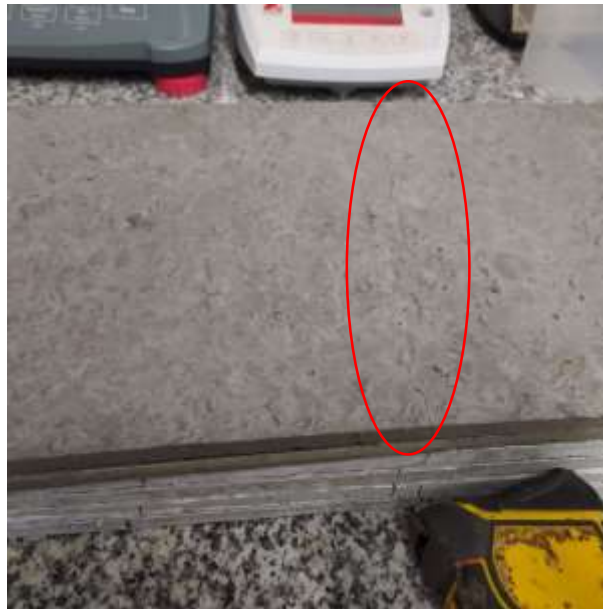
Imagen 31: Aparición de grieta después de fallada.
