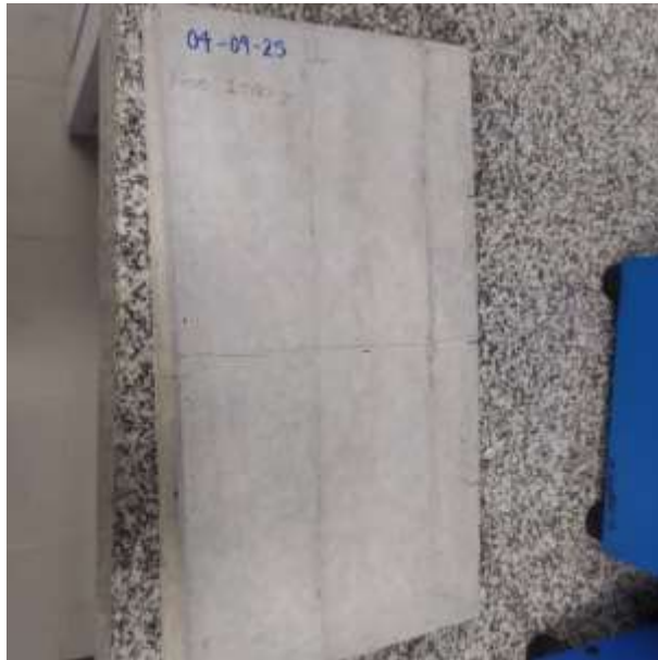
Imagen 41: Aparición de grieta después de fallada.
