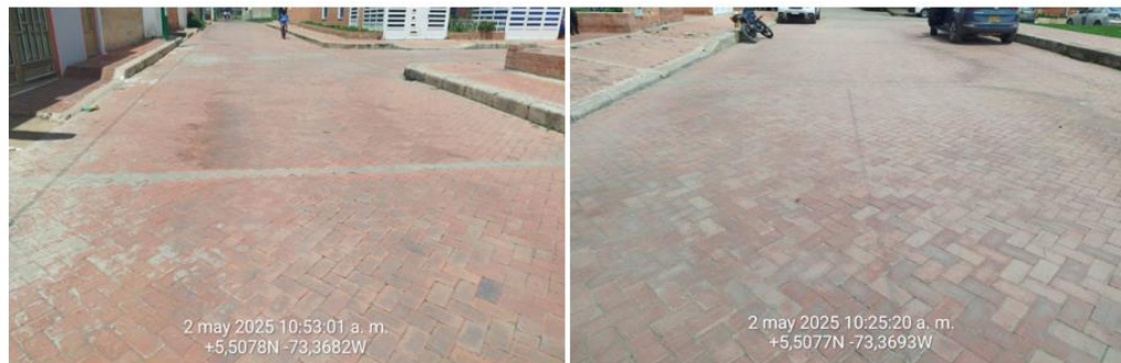
Figura 15. Pavimento articulado.
