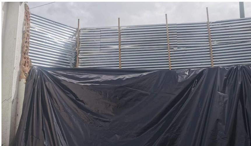
Figura 35. Impermeabilización del talud.
