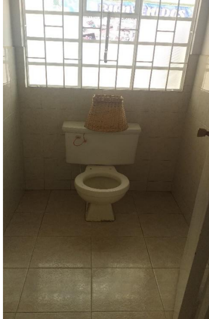
Ilustración 3 Baño a mejorar para discapacitados.
