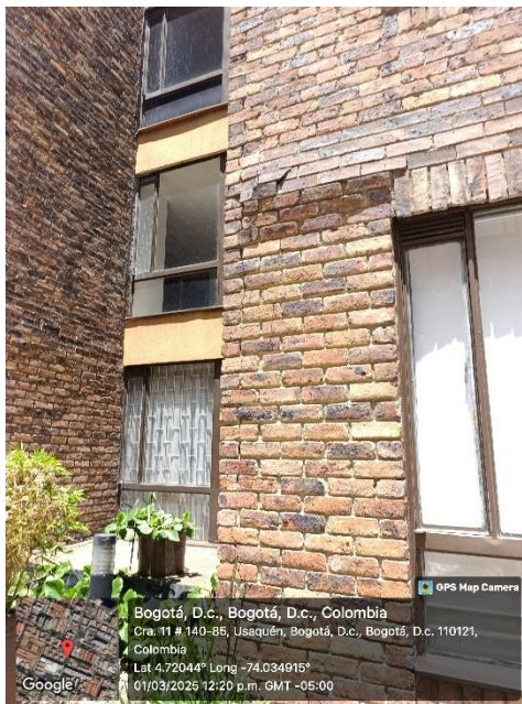
Ilustración 13. Fachada, elemento no estructural Archivo: Fuente propia
