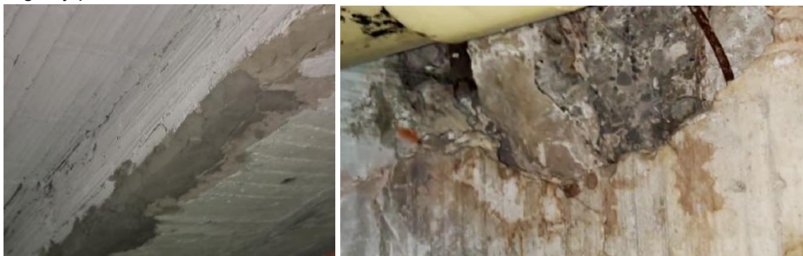
Ilustración 14. Viga y placa, elemento estructural Archivo: Fuente propia
