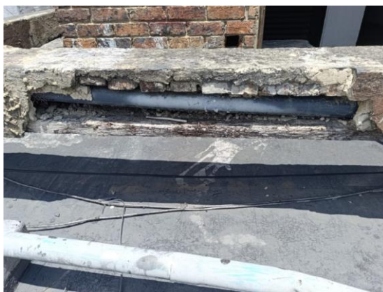
Ilustración 12. Viga en ladrillo, elemento estructural Archivo: Fuente propia
