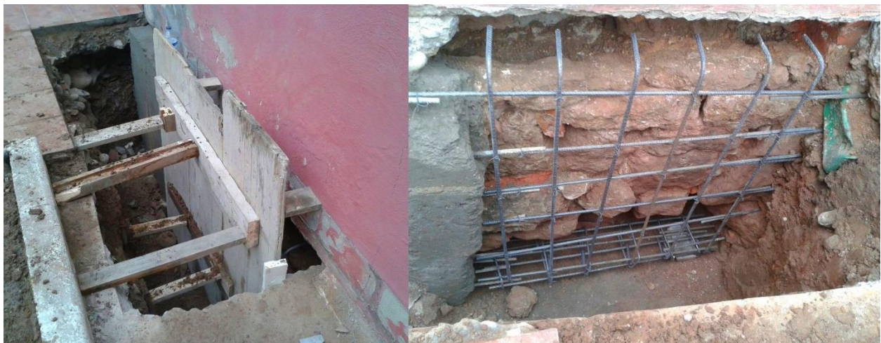
Ilustración 42 Reforzamiento cimentación (Fuente. Abacotecnica.com - Google)
