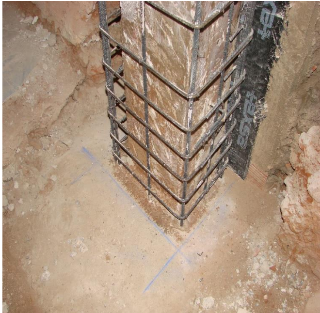
Ilustración 43 Recalce de columnas (Fuente Google)
