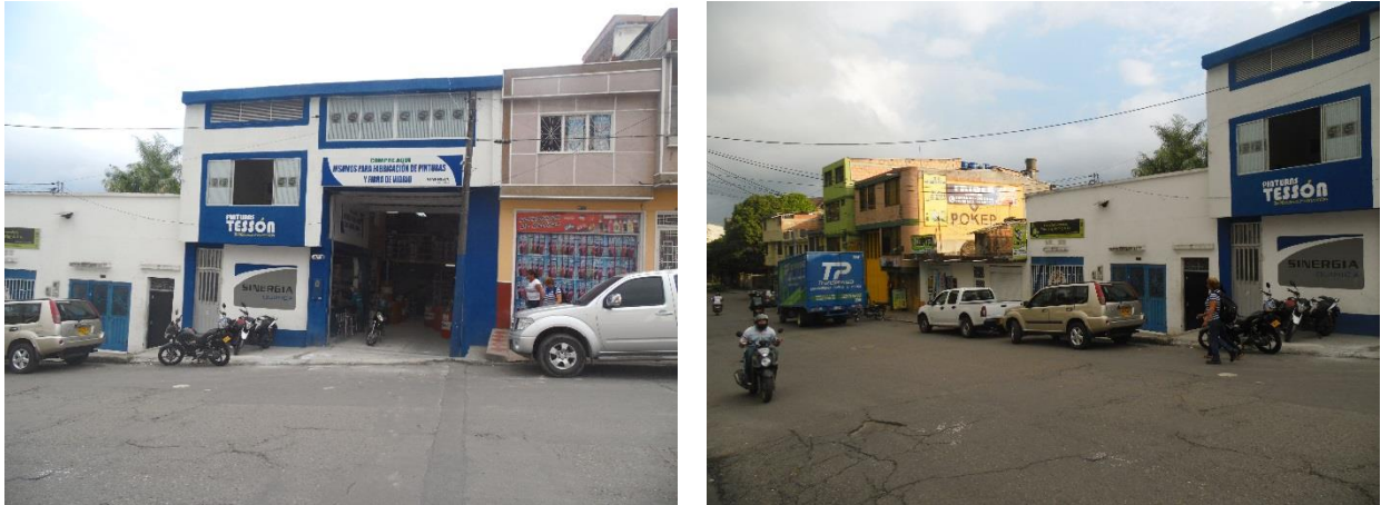
Ilustración 14 Edificación y obras vecinas (Fuente. Los Autores)
