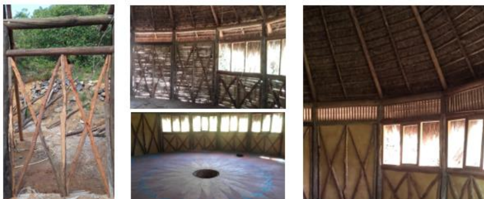
Figura 43. Construcción en madera utilizando técnicas vernáculas en Curití Santander
