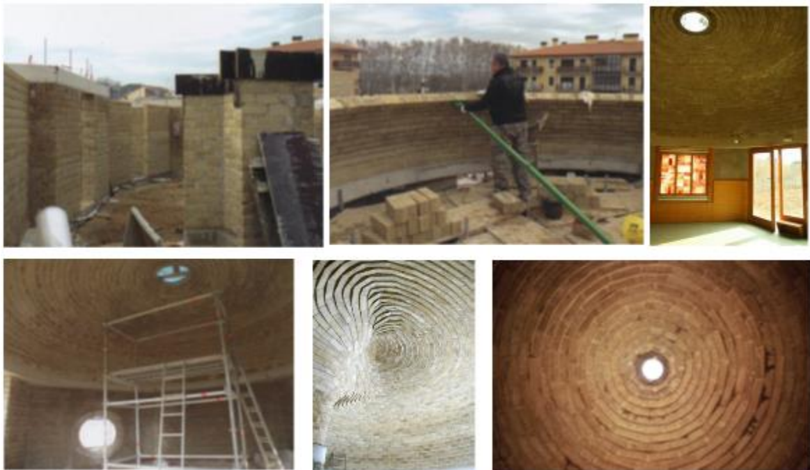
Figura 54. Galería de imágenes proceso construcción con BTC Escuela Infantil, Catalunya
