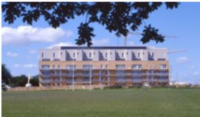
Figura 48. Galería Residence Salvatierra, France
