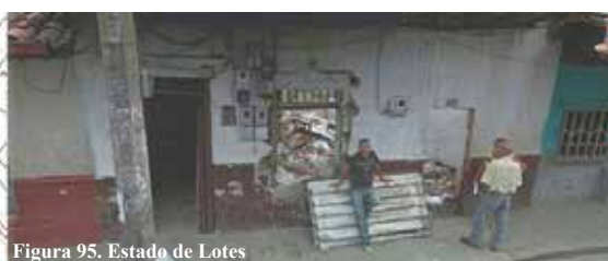
Figura 95. Estado de Lotes Deteriorado – Abandonado
