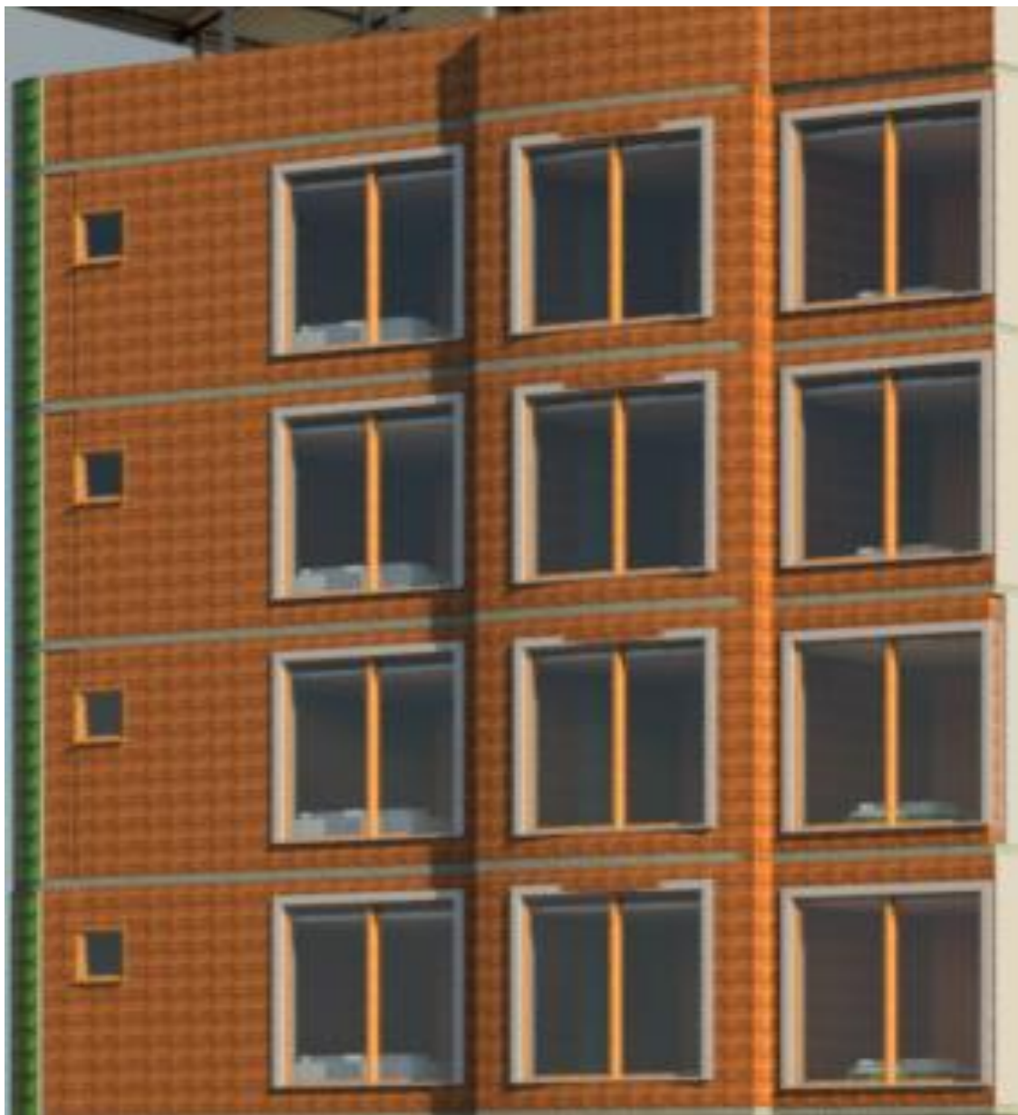
Figura 18. Implementación en Muros Internos y Fachada de Ladrillo de Madera.
