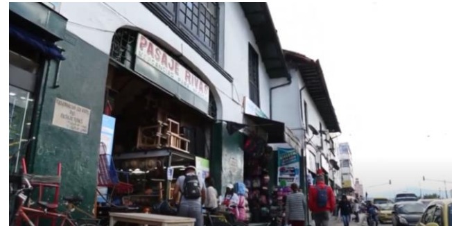
Fachada del Pasaje Rivas
