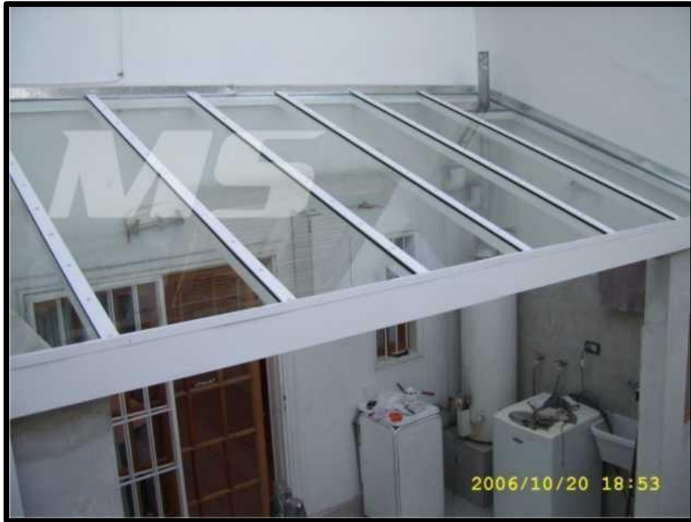
Fig. 23 Instalación de techos translucidos
