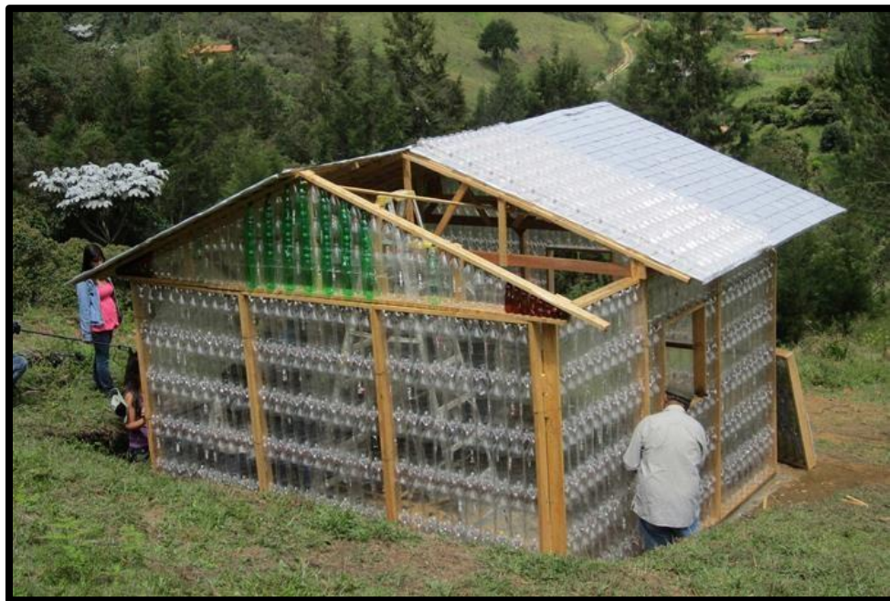
Fig. 57 Aprovechamiento de materiales de construcción reciclados
