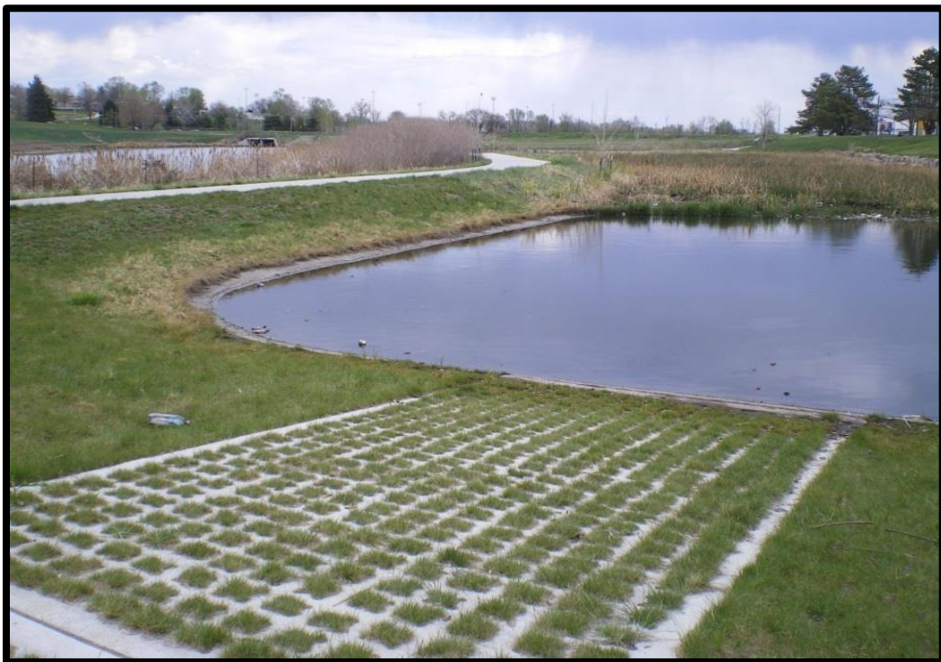
Fig. 61 Sistemas de retención de agua lluvia
