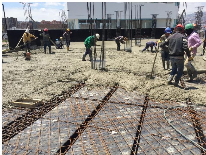
Imagen 12. Fundida de vigas, viguetas y placa
