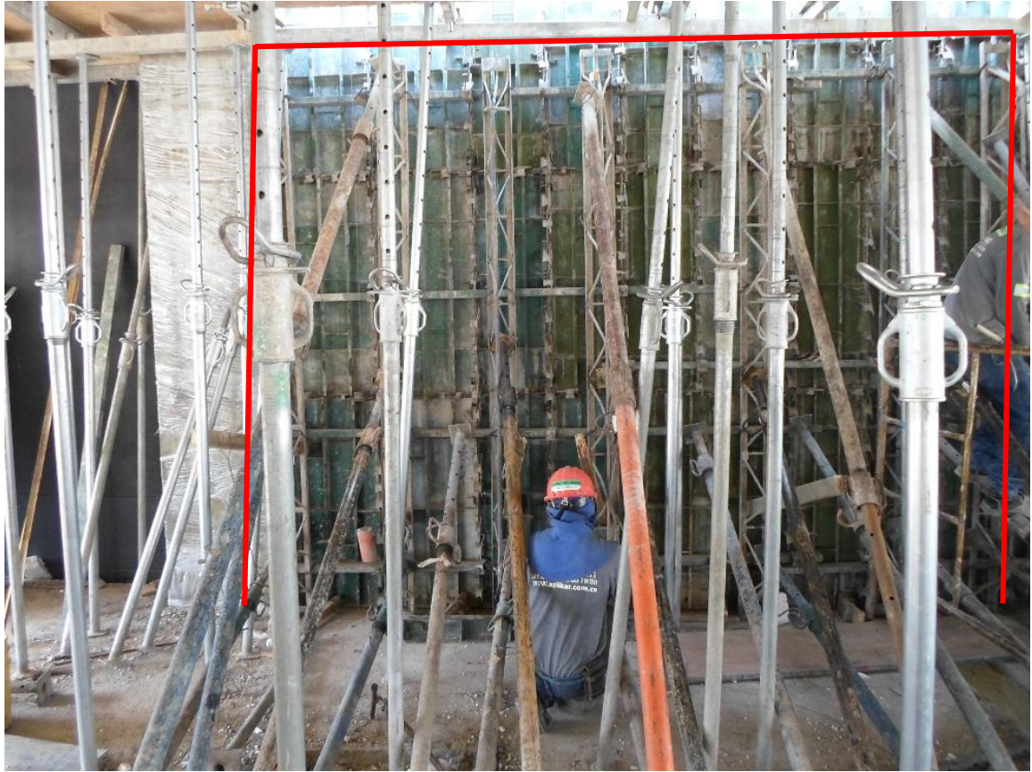
Imagen 9. Encofrado de pantalla 1
