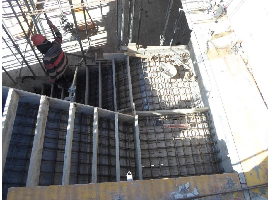
Imagen 6. Armado de escalera
