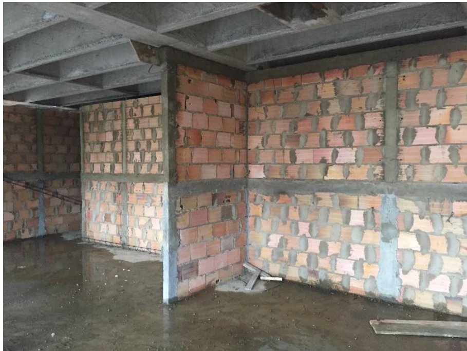
Imagen 16. Muros primer piso
