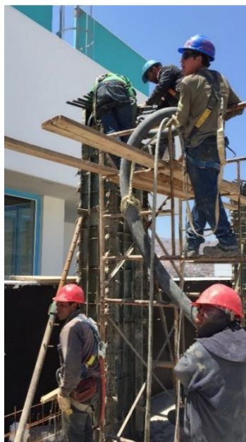
Imagen 13. Fundida de columnas
