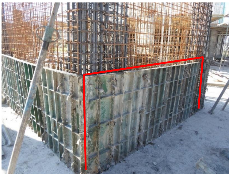
Imagen 8. Encofrado de pantallas
