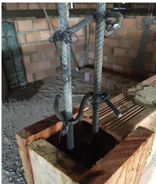
Imagen 17. Armado de columnetas en muros
