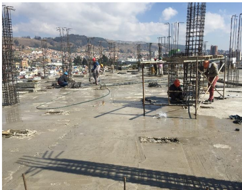
Imagen 14. Hidratación de placa posterior a fundida
