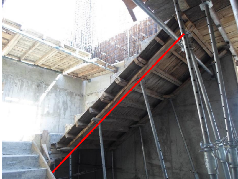
Imagen 10. Encofrado de escalera
