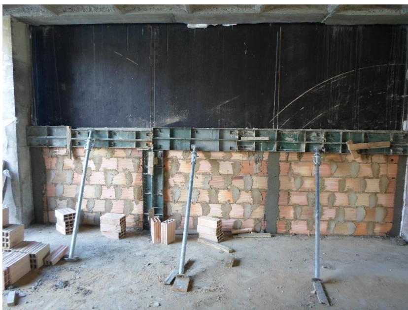
Imagen 18. Vigas cinta en muros primer piso
