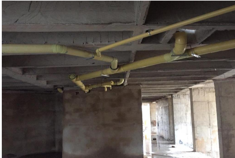
Imagen 24. Bajante por ducto de red aguas negras en piso 1
