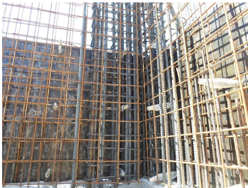
Imagen 2. Armado de pantallas
