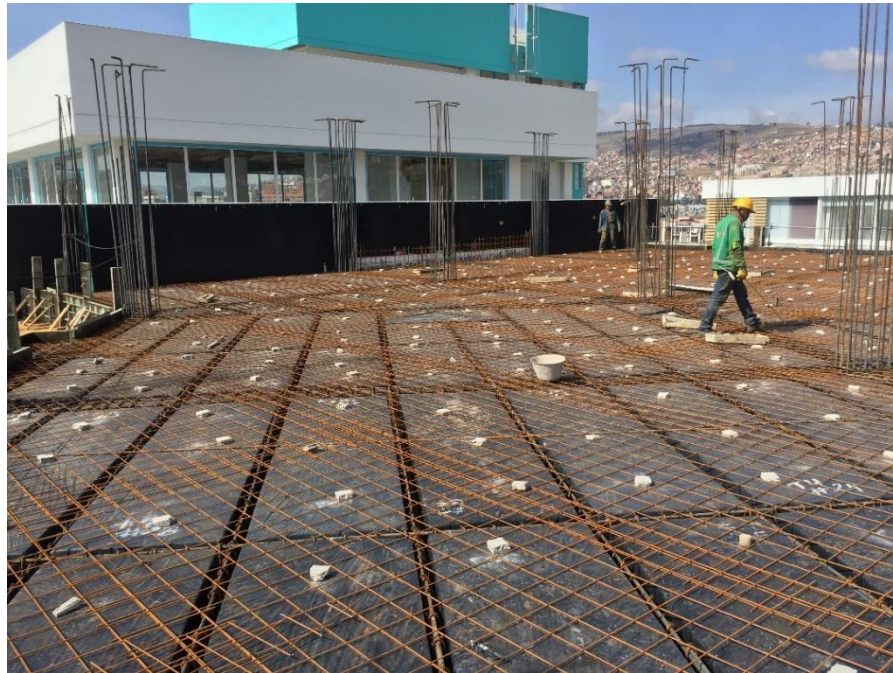
Imagen 4. Armado de placa
