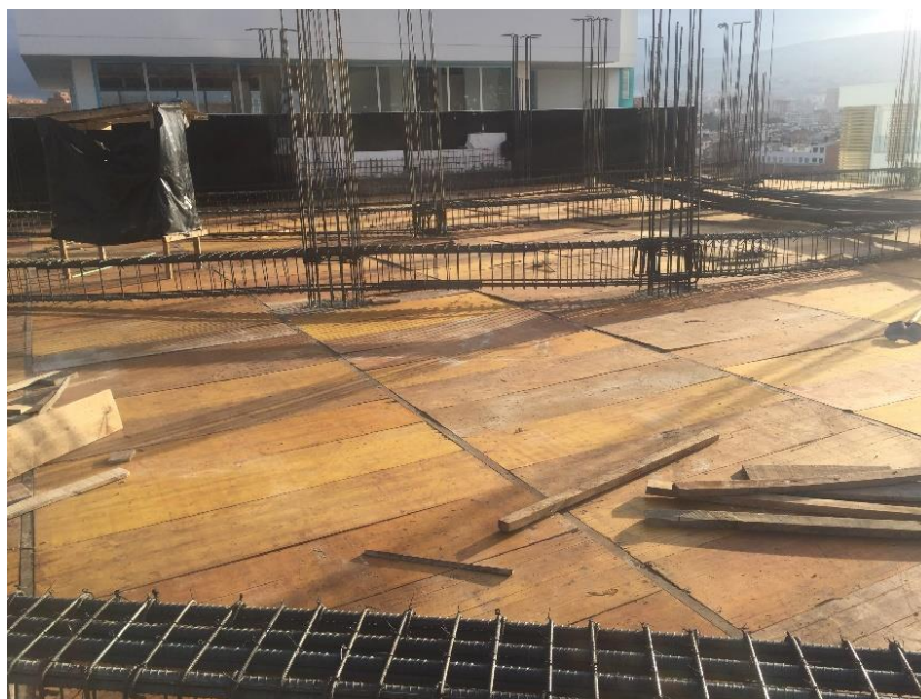
Imagen 3. Armado de vigas principales y placa
