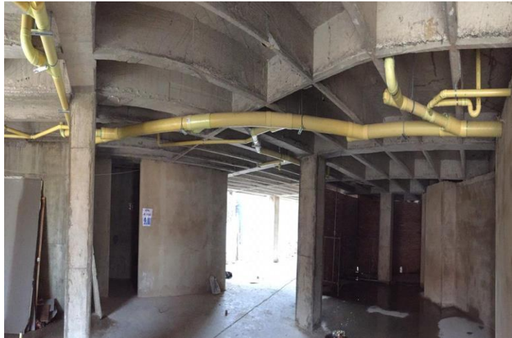
Imagen 23. Inicio de colector 1 red de aguas negras en piso 1
