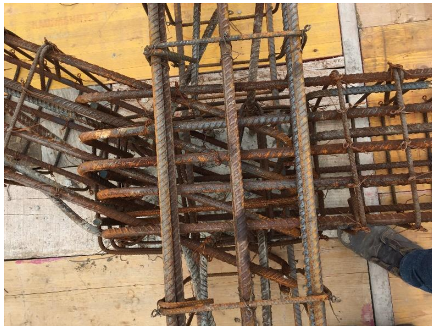
Imagen 1. Armado de vigas principales
