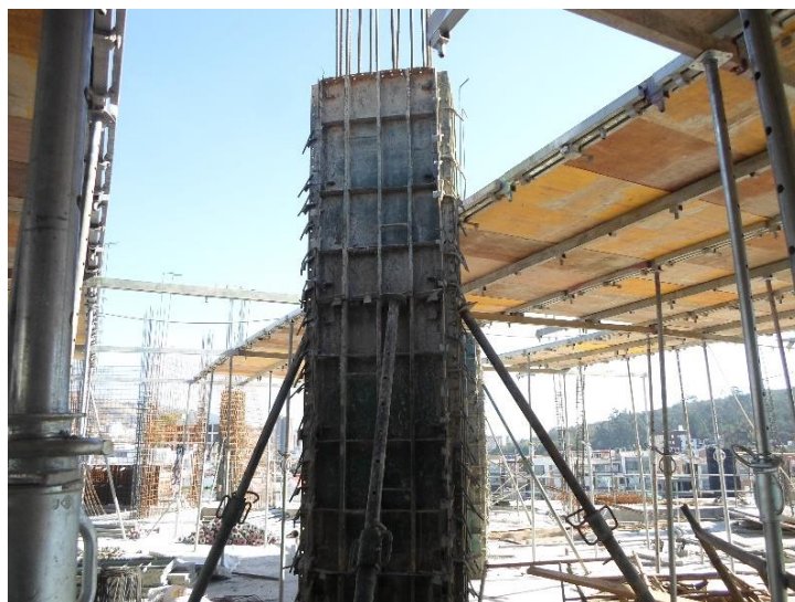
Imagen 7. Encofrado de columna
