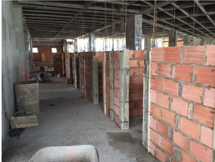
Imagen 19. Muros segundo piso
