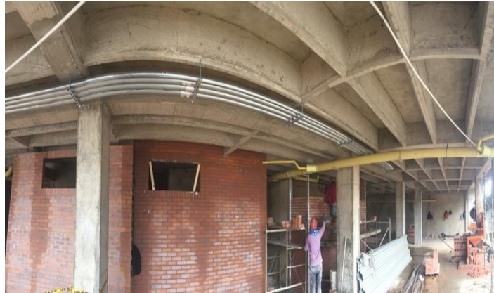
Imagen 21. Salida de colector de red aguas negras y parciales en piso 1
