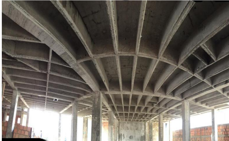
Imagen 20. Estructura piso 3 en obra
