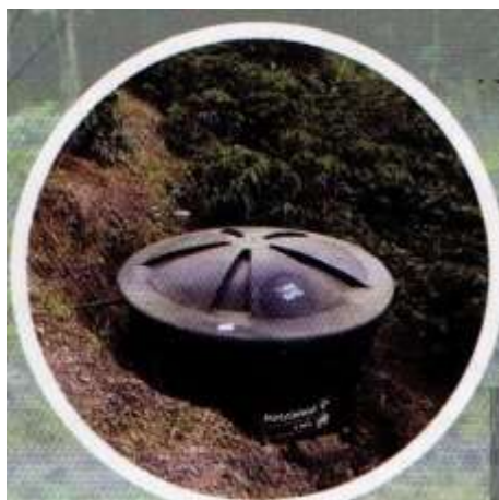
Figura 22. Tanque de lixiviados
