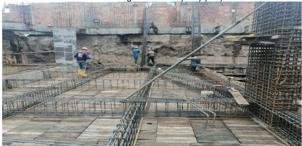
Ilustración 39. Armado de vigas sótano 1 (E-H) (9-8)
