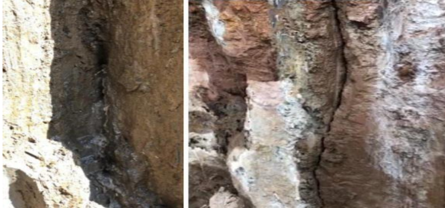
Ilustración 6. Dilatación de pantalla por junta constructiva
