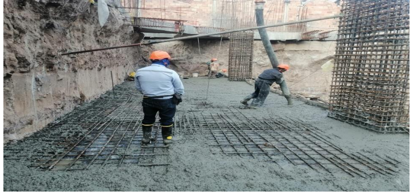
Ilustración 21. vaciado placa sótano 1 ejes (E-H) (10-9)
