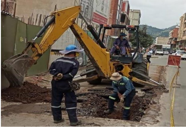
Ilustración 22. Demolición y retiro de carpeta asfáltica
