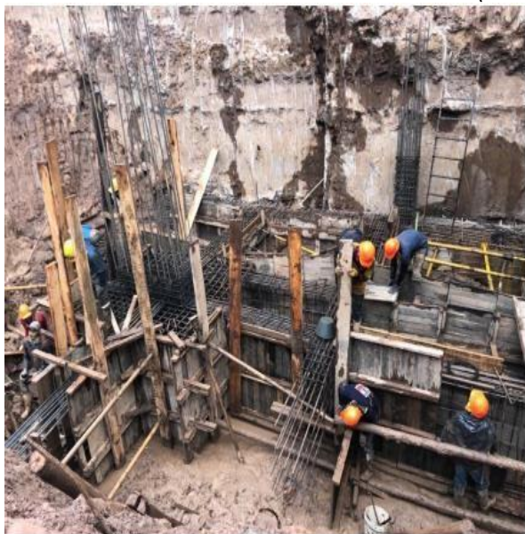
Ilustración 11. Proceso de vaciado dado (G-9)
