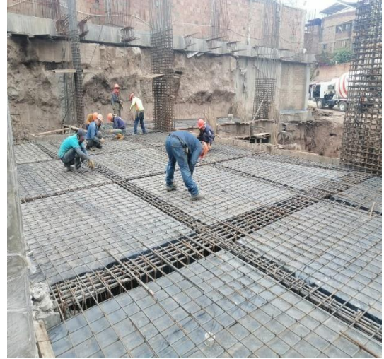
Ilustración 41. Armado parrilla sup. Placa s1
