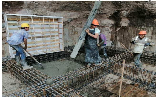
Ilustración 38. Vaciado con parrilla inferior placa sótano 1 ejes (J-k) (10-9)
