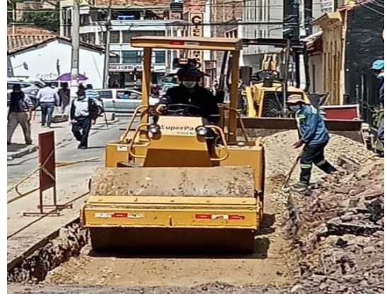
Ilustración 23. Compactación material
