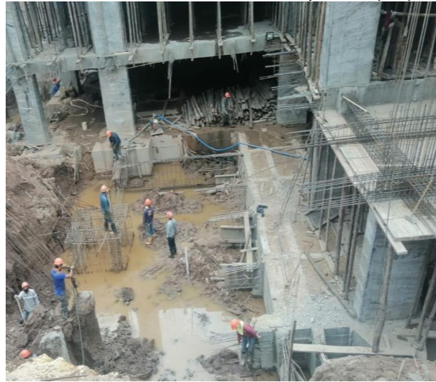
Ilustración 53. Descabece de pilotes (D4)
