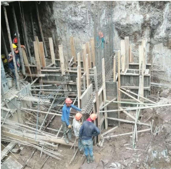
Ilustración 19. Encofrado dado (D8) y(vc43)
