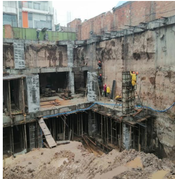
Ilustración 37. Encofrado Columna (c15) (M5)
