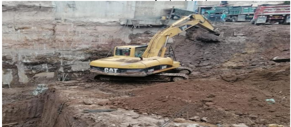
Ilustración 30. Excavación N-12.60 ejes (E-F) (8-7)
