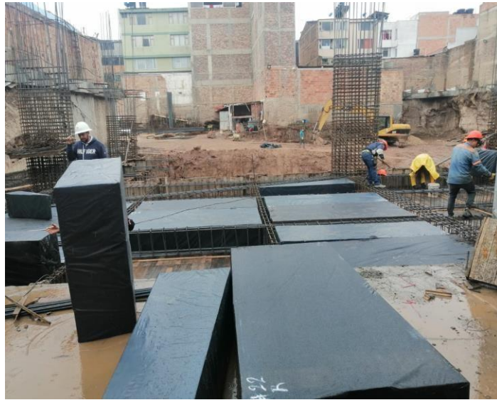
Ilustración 42. Ubicación de casetón de icopor placa sotano1 (E-H) (9-8)
