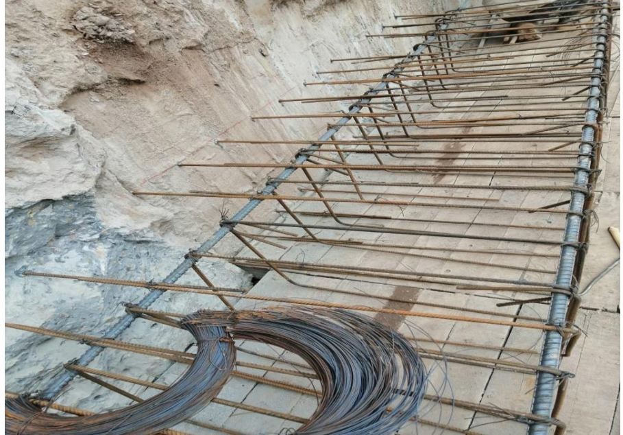
Ilustración 34. Anclaje de acero viga perimetral (Vs1-054)
