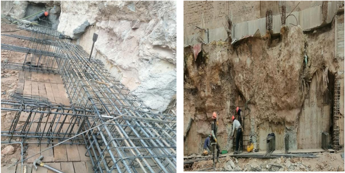
Ilustración 49. Anclaje viga sotano1 (Vs1-071) Ilustración 50. anclaje vigassótano 1 (vs1-037-034-029)
