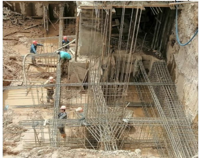
Ilustración 46. Armado del Dado (D4)
