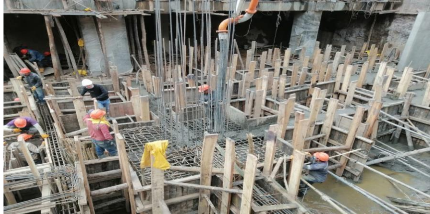
Ilustración 29. Vaciado placa de cimentación ejes (E-H) (10-9)
