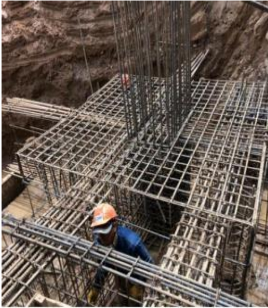
Ilustración 16. Armado de dado (D2)
