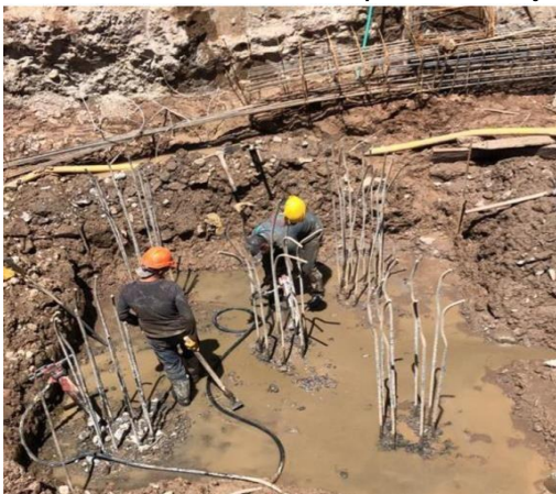
Ilustración 7. Descabece pilotes D2 ejes (G-9).
