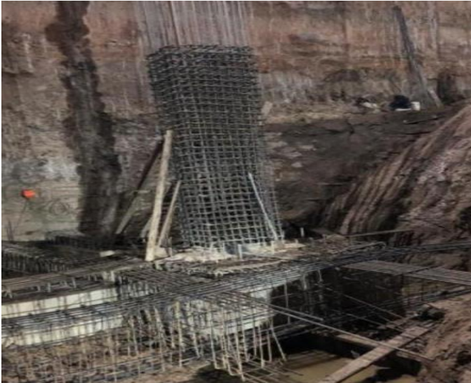
Ilustración 4. Acero de refuerzo, Columna (C18)
