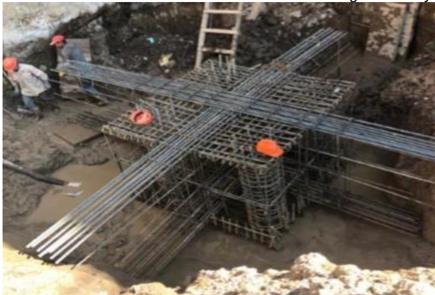
Ilustración 1. Parrilla de acero de refuerzo dado D1 con vigas VC-27 y VC-44
