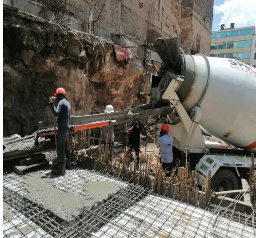
Ilustración 57. Vaciado de placa s1 ejes (J-k) (2-3)
