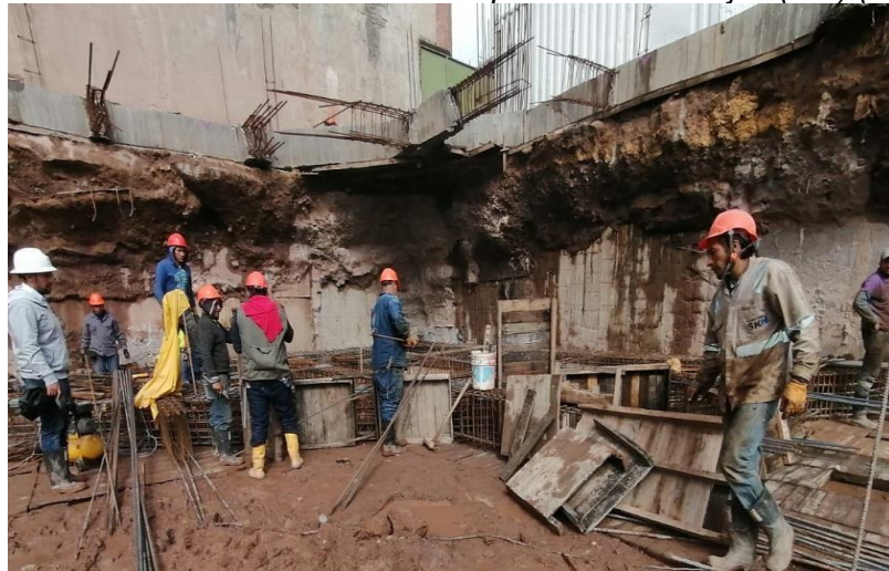
Ilustración 35. Armado de formaleta placa sótano 1 ejes (J-K) (10-9)
