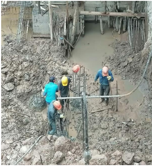
Ilustración 43. Descabece de pilotes dado D4
