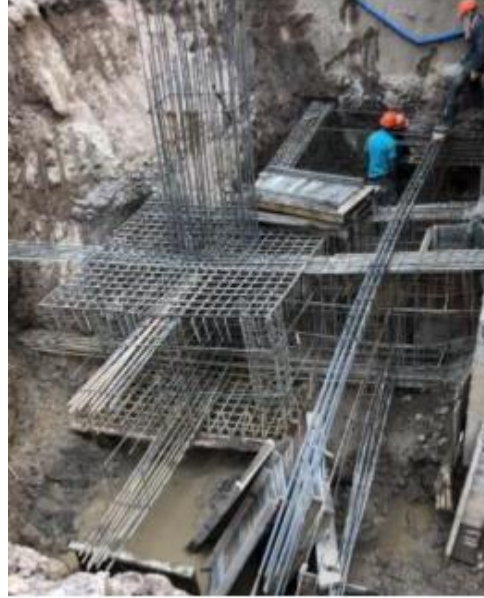
Ilustración 17. Armado dado (D2) y Vc49 vc50
