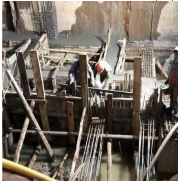
Ilustración 12. Proceso de vaciado dado(G-9)
