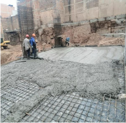
Ilustración 40. Vaciado Placa sótano 1
