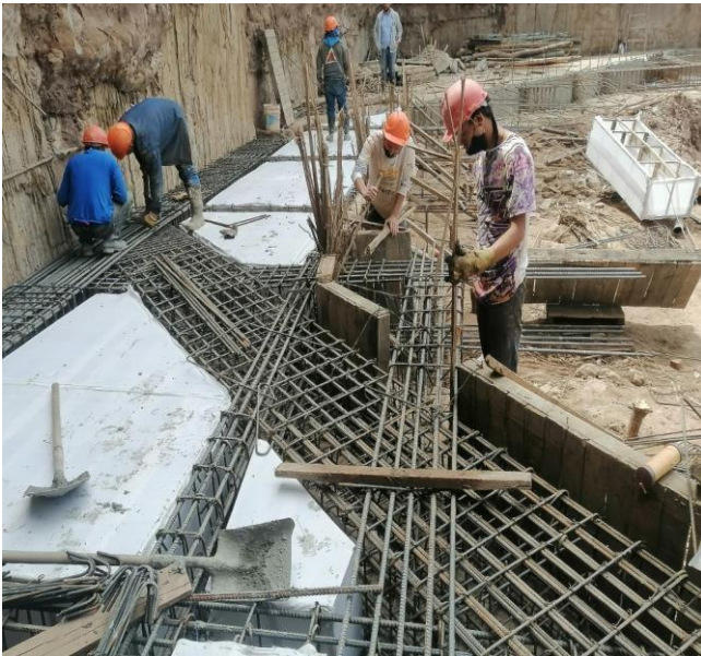
Ilustración 47. Armado de placa s1 ejes (J-K) (8-6)
