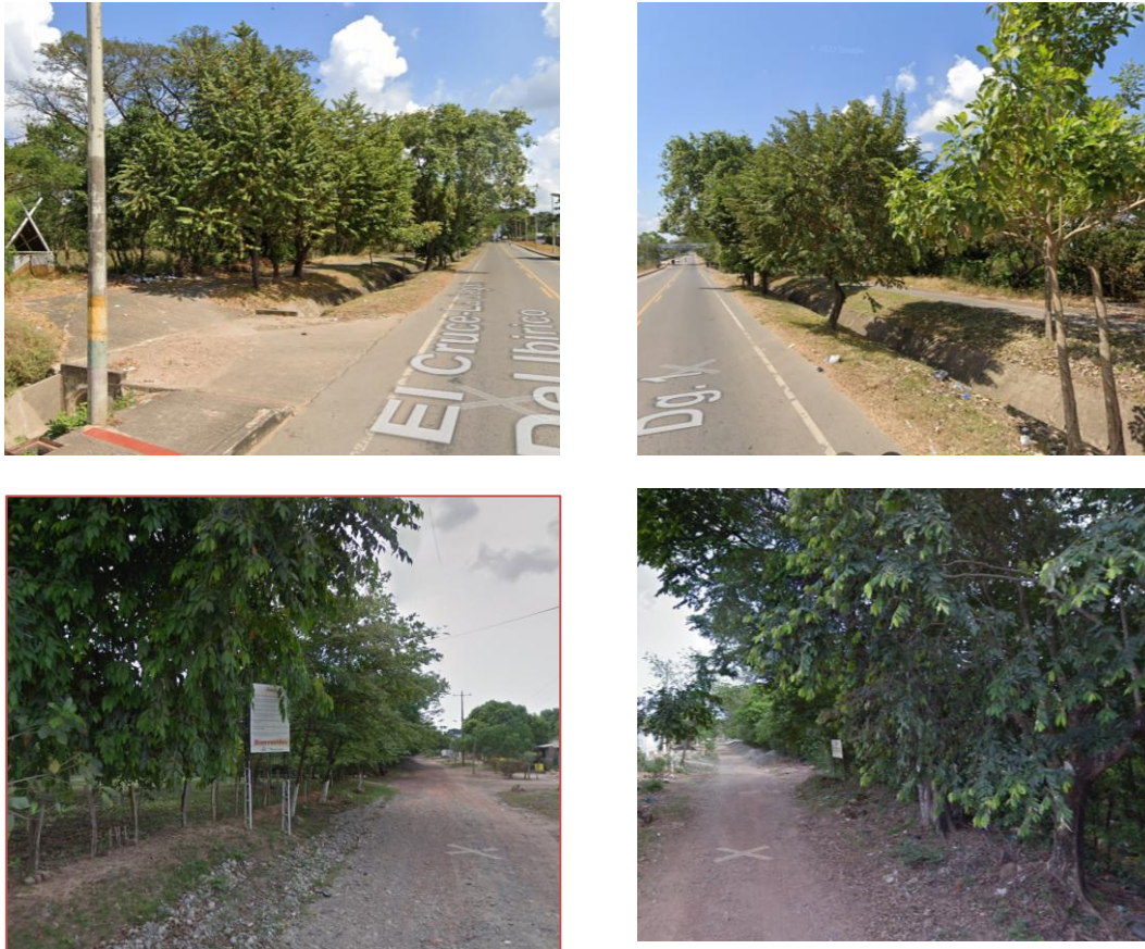
Figura 24. Imágenes estado actual. Elaboración propia.
