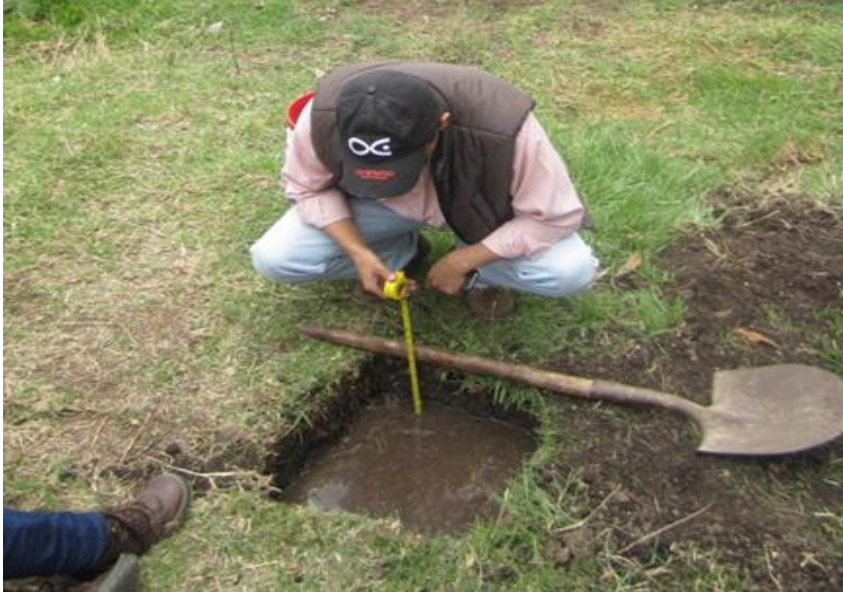
Fotografía. Realización de pozo 40x40. Para medir permeabilidad in-situ.
