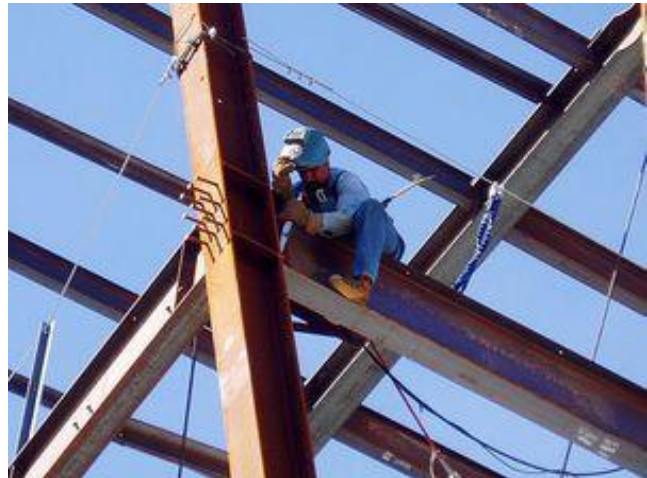
Gráfico 23: Estructura metálica Fuente: http://www.construmatica.com
