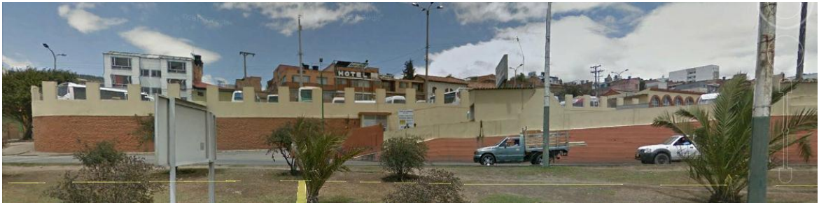
Imagen 21: Vista del lote sobre la avenida Oriental
