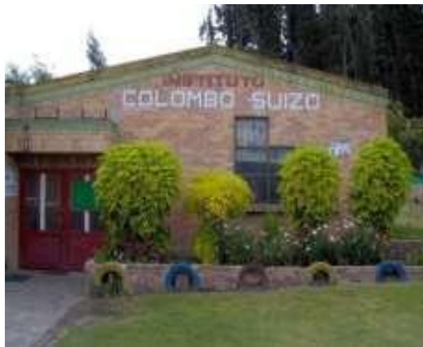
Imagen 16: Fachada Fundación Colombo Suizo
