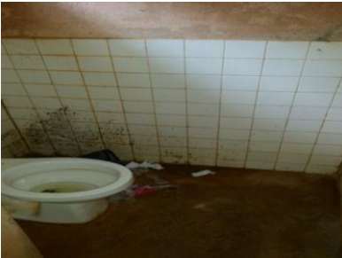
Estado Unidad Sanitaria
