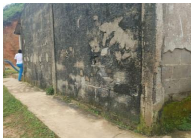
Estado Estructura Exteriores
