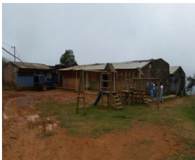
Estado de la Escuela.
