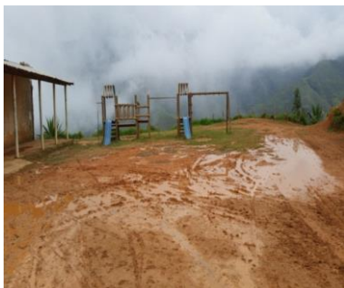
Estado del Patio y Zona de Juegos
