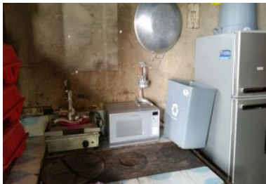
Estado de la Cocina
