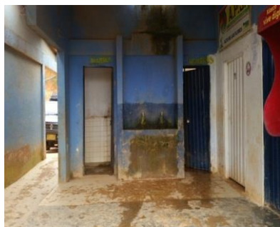
Estado de Baterías Sanitarias
