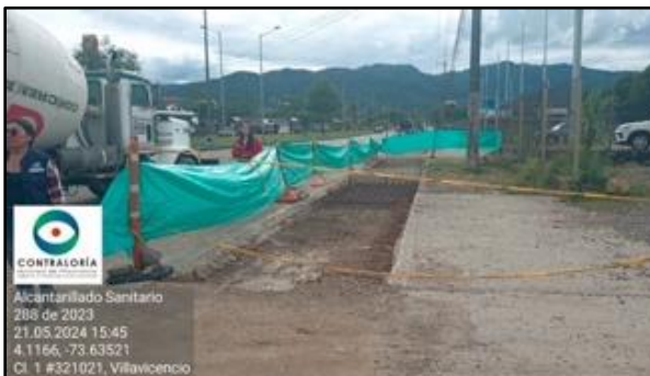
Imagen 3. Visitas a obra de alcantarillado sanitario
