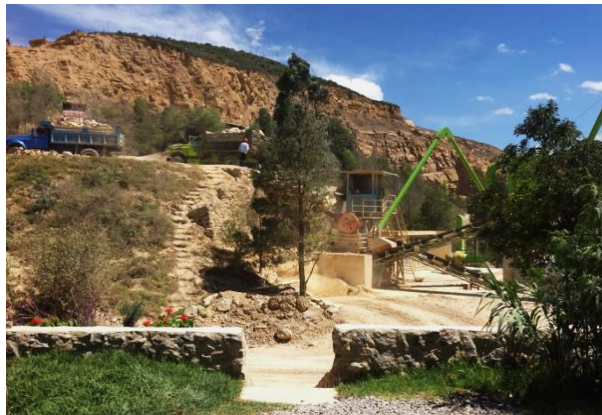
Figura 24. Fuente de material grueso Piedras y Gravas S.A.
