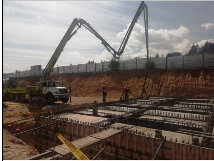
Figura 30. Tanque de Almacenamiento Vaciado de Concreto
