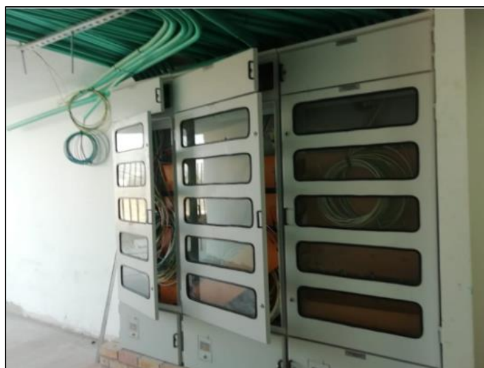
Figura 19 Instalación de Cableado y aparatos eléctricos
