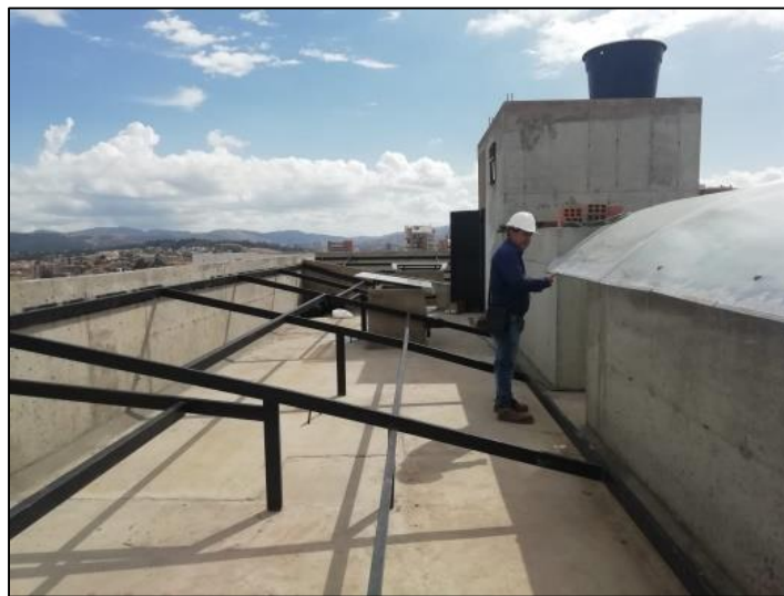
Figura 37. Estructura Metálica de la Cubierta
