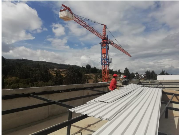
Figura 20 Instalación de cubierta
