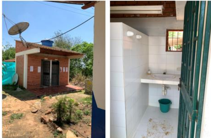
Figura 33. Baterías sanitarias de la escuela rural El Espinal.
