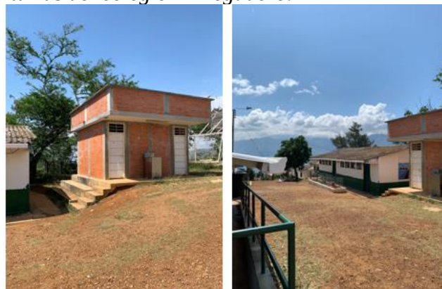
Figura 38. Baterías sanitarias del colegio El Regadero.
