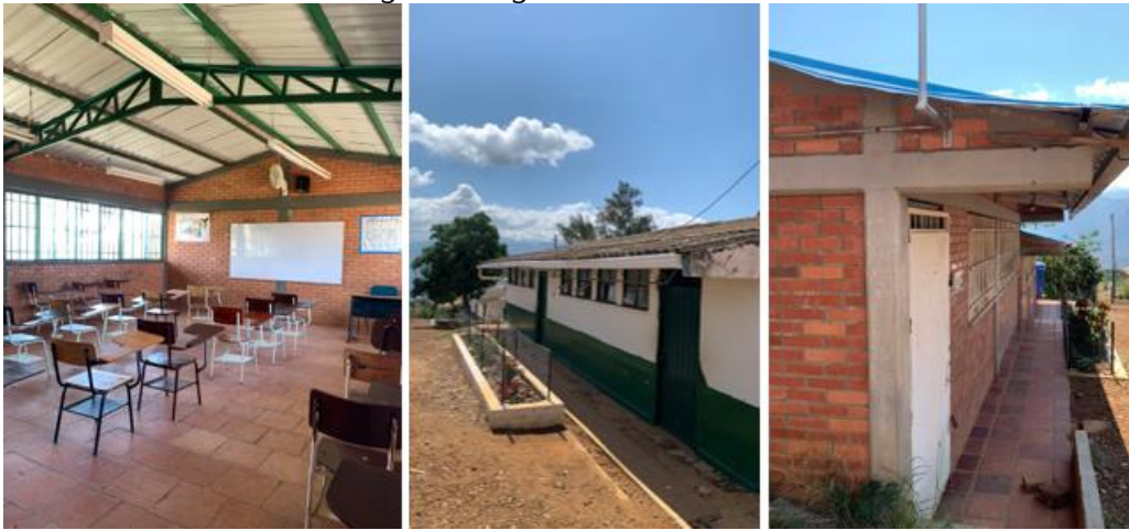
Figura 39. Aulas de clases del colegio El Regadero.
