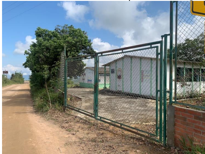
Figura 6. Acceso de la sede C. Este se da través de un portón de acero y malla metálica.
