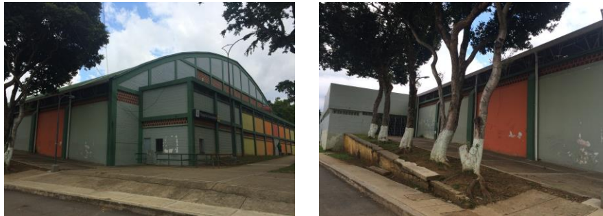
Figura 22. Imágenes de la fachada del coliseo de baloncesto.
