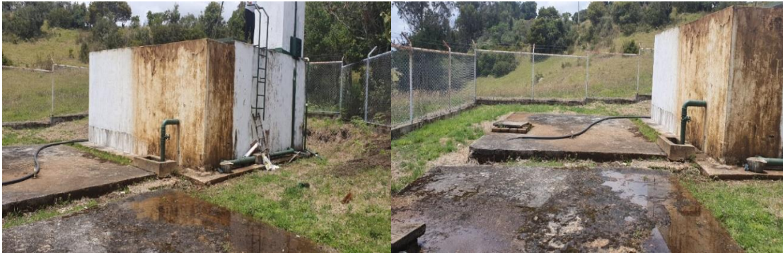
Figura 12. Estado actual de la planta de tratamiento de agua potable de la vereda El Salitre
