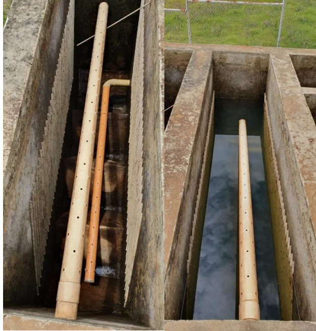
Figura 16. Estado actual del sedimentador de la planta de tratamiento
