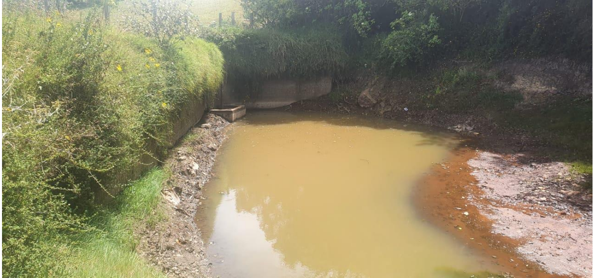
Figura 10. Fuente de abastecimiento
