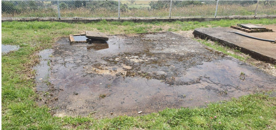
Figura 18. Estado actual del tanque de almacenamiento de la planta de tratamiento
