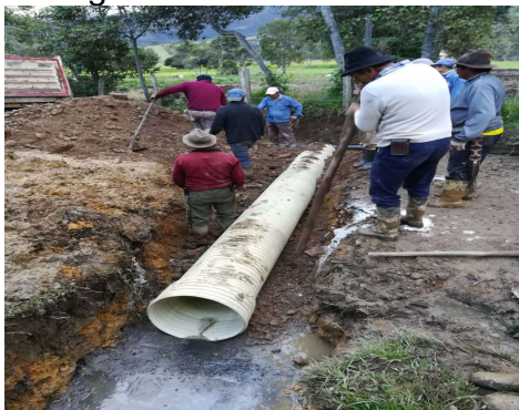
Figura 13. Puesta del tubo.
