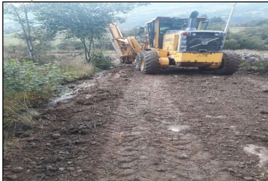
Figura 9. Limpieza y demarcación de cunetas Vereda Caracoles Bajo.
