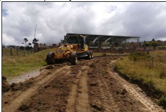
Figura 6. Limpieza y demarcación de cunetas.
