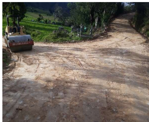
Figura 20. Compactación del material.
