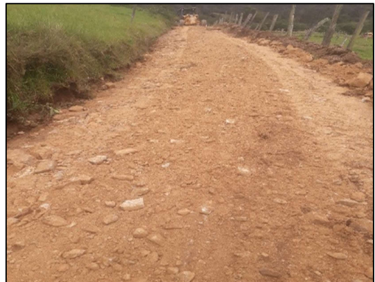
Figura 17. Extendida y compactación de material de recebo.
