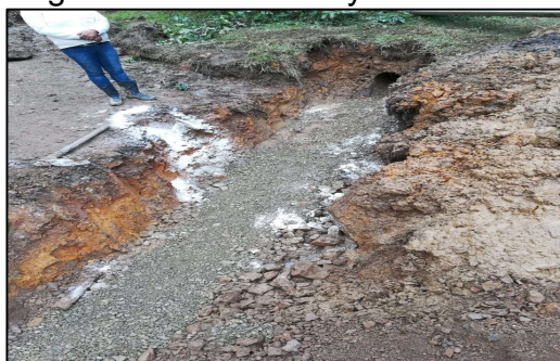
Figura 12. Nivelación y adecuación.
