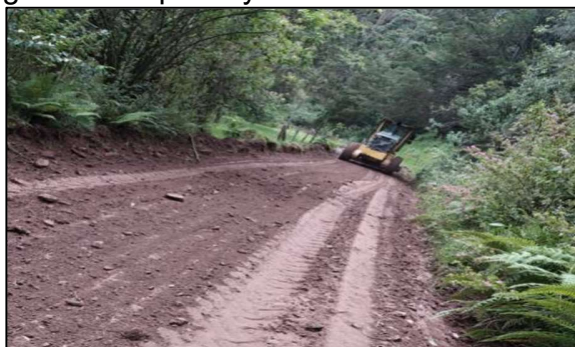
Figura 3. Limpieza y demarcación de cunetas.
