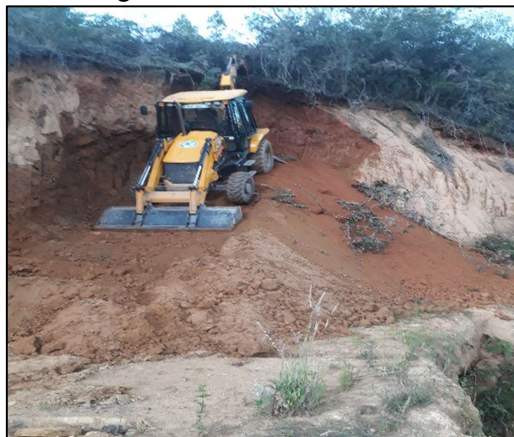
Figura 25. Corte de talud.
