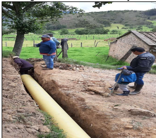
Figura 21. Obra de drenaje.
