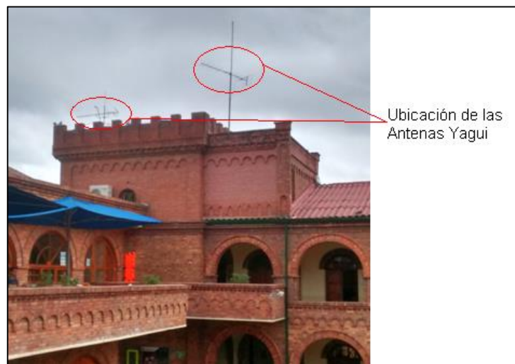
Figura 37 Ubicación de las Antenas Yagui
