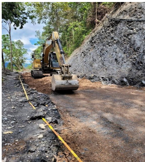
Figura 12: Continuación de mejoramiento en vía de acceso a patio.
