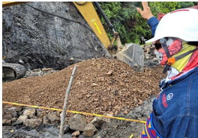
Figura 9: Esparcimiento del recebo para poder continuar a su respectiva compactación. Fuente: Elaboración propia (2022).
