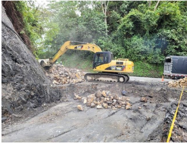
Figura 8: Se introduce el rajón para el mejoramiento del acceso a patio. Fuente: Elaboración propia (2022).
