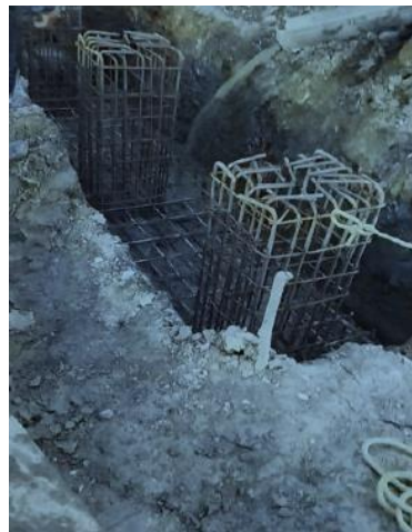
Figura 5: Despiece de aceros en pedestales y fundida de zarpa. Fuente: Elaboración propia (2022).
