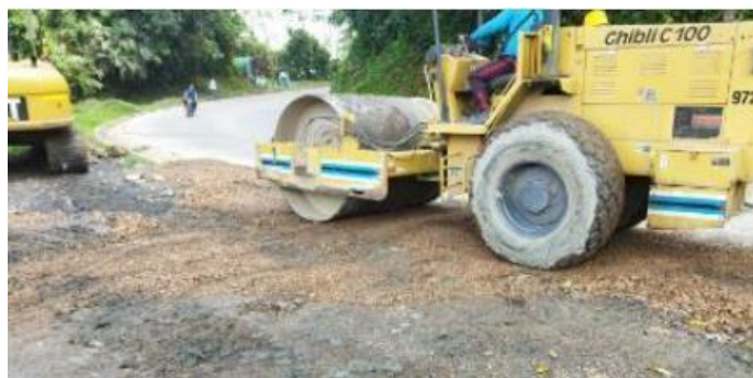
Figura 11: Acompañamiento a la actividad de relleno en cuneta de vía principal y en la intersección de la vía de acceso al patio.
