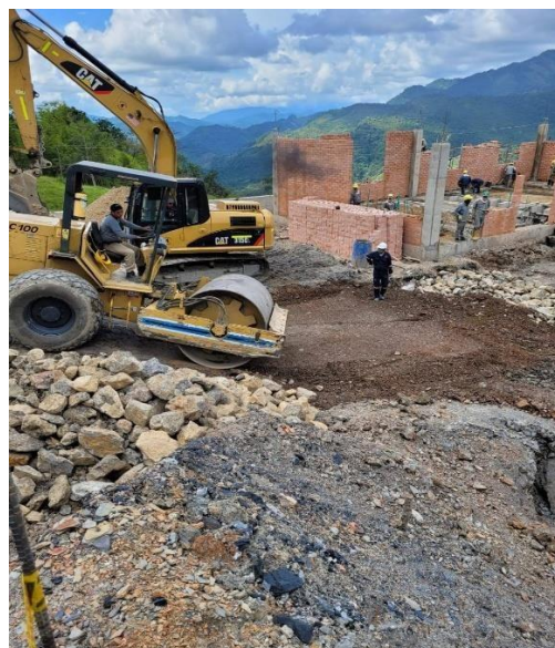
Figura 16: Compactación de material para el mejoramiento de suelo al ingreso de patio. Fuente: Elaboración propia(2022).
