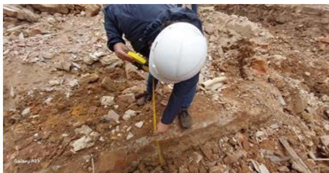
Figura 21: Medidas para nivelación de piso en sala de tableros Fuente: Elaboración propia (2022).
