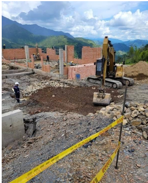
Figura 15: Esparcimiento de recebo con retroexcavadora. Fuente: Elaboración propia(2022).
