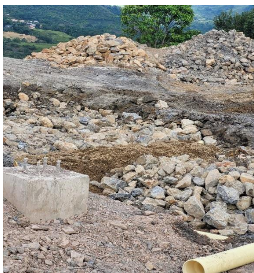
Figura 13: Mejoramiento de suelo con rajón y recebo para el ingreso a patio.
