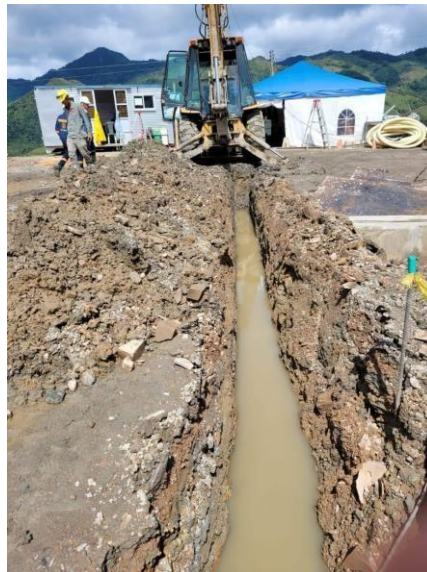
Figura 6: Supervisión de excavación mecánica para cárcamo. Fuente: Elaboración propia (2022).
