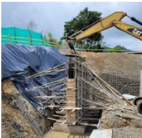
Figura 19: Fundida muro de contención costado sur de patio. Fuente: Elaboración propia (2022).
