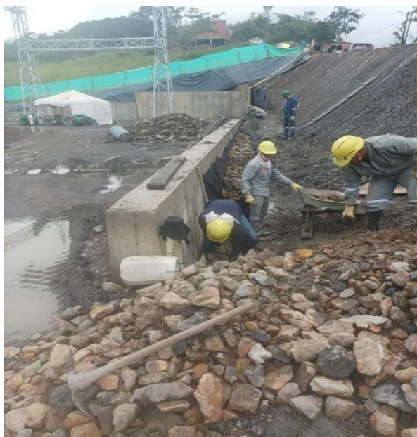
Figura 20: Instalación de manguera y piedra filtro a muros de contención para su drenaje. Fuente: Elaboración propia (2022).
