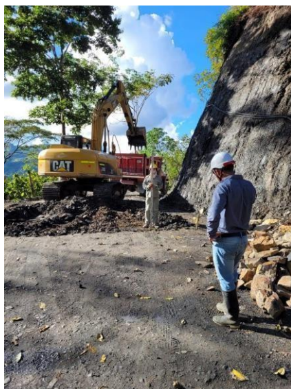
Figura 7: Excavación mecánica entre vía intersección a patio y vía principal. Fuente: Elaboración propia (2022).
