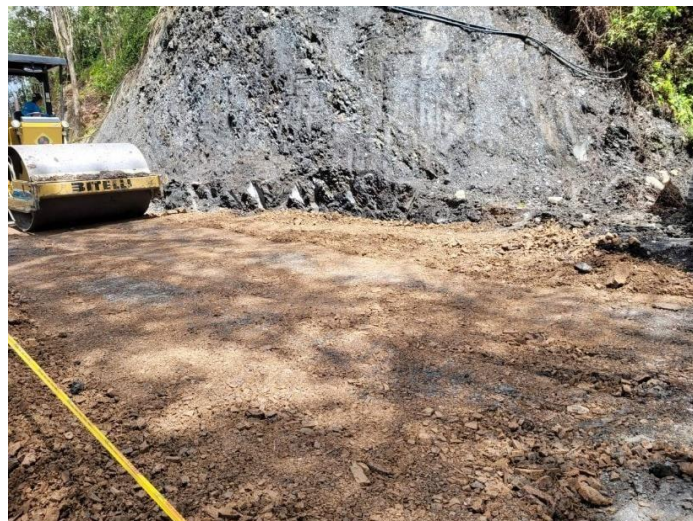
Figura 10: compactación de rajón y recebo de la vía de acceso a patio desde la intersección vial principal. Fuente: Elaboración propia (2022).
