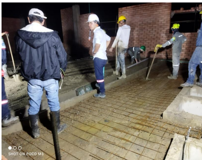
Figura 22: Instalación de malla electrosoldada para piso en sala de tableros. Fuente: Elaboración propia (2022).
