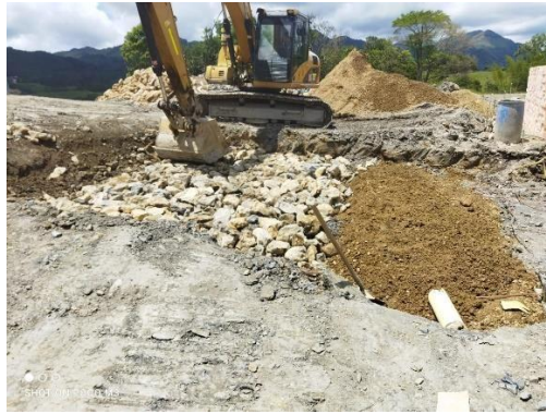
Figura 14: compactación con retroexcavadora de rajón. Fuente: Elaboración propia(2022).
