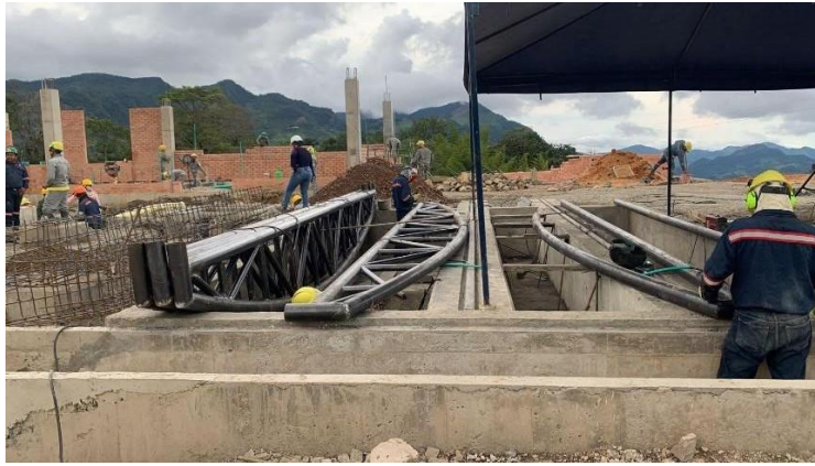
Figura 23: Supervisión de la estructura para la cubierta Fuente: Elaboración propia. (2022).
