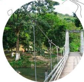
Figura 16. Fotografía puente colgante, Google.com/maps
