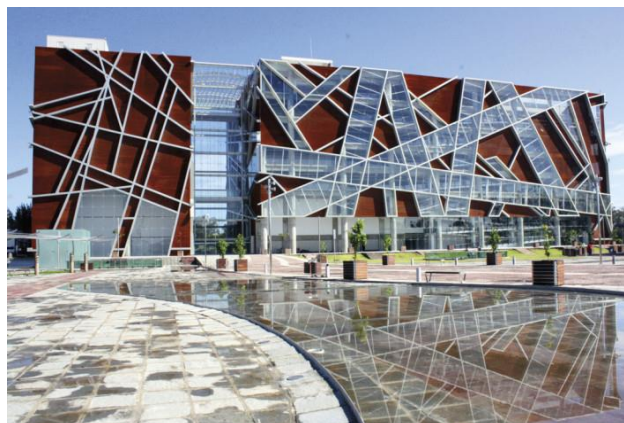
Figura 11. Biblioteca pública del estado de Jalisco. Adaptada de construirtv.com
