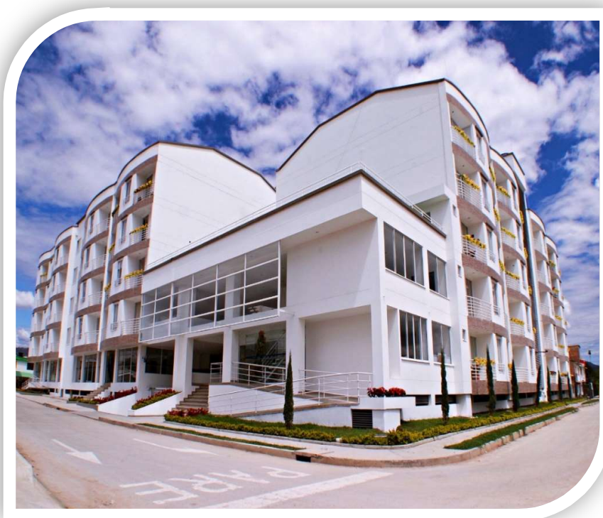
Ilustración 40.- Fachada exterior edificio Reserva de los Lagos
