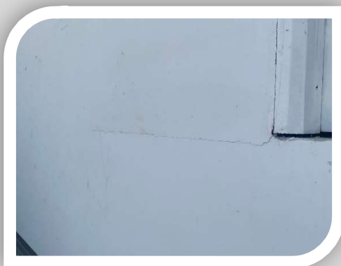
Ilustración 10.- Fisura en pie de puerta lesión 2
